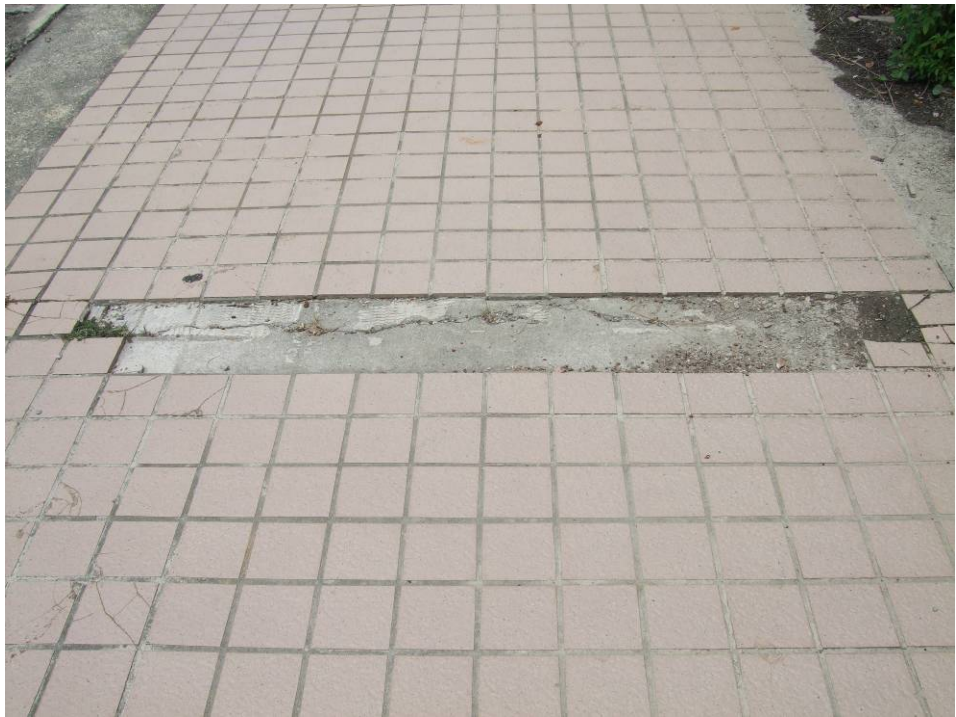
圖3-22 地點：彰化縣鹿港鎮建國路
