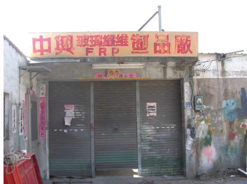
圖 1-2-6-3 中興玻璃纖維 FRP 製品廠
