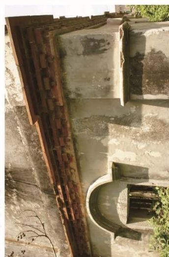
3. 主棟洋樓背立面
