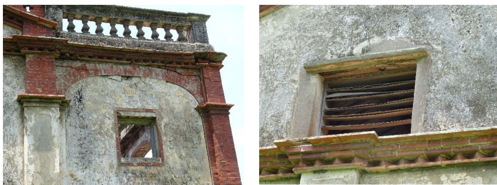
圖 40 主棟右側立面二樓前廊及山牆氣窗壁面以水泥塗抹，再飾以油漆粉刷
