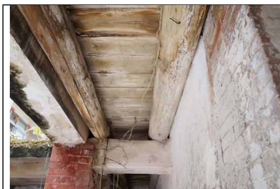
照片 25 前迴向一樓騎樓明間樑
