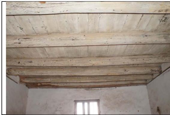
照片 33 前迴向一樓次間樑
