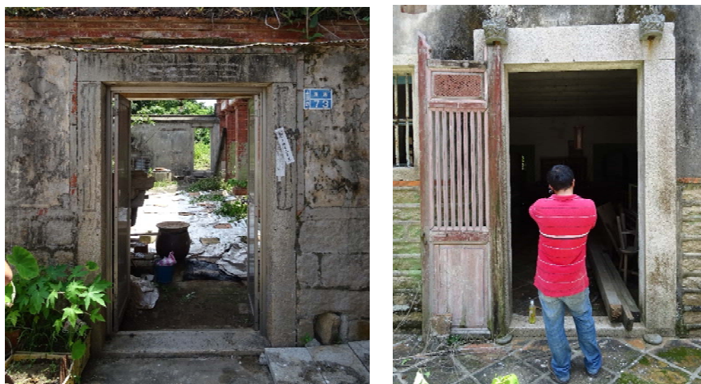
圖 41 全區主入口及主棟洋樓一樓門口用花崗條石構成開口及平砌牆基
