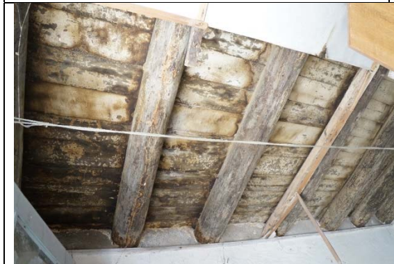
照片 35 前迴向一樓次間樑
