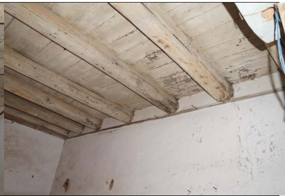
照片 34 前迴向一樓次間樑
