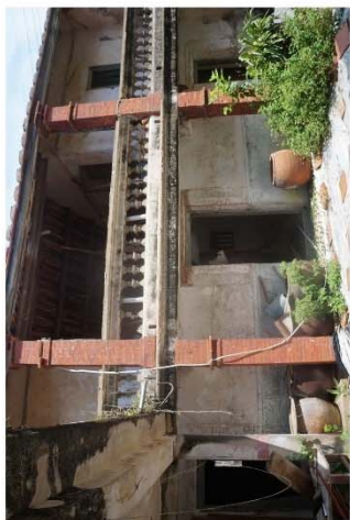
前迴向洋樓正立面
