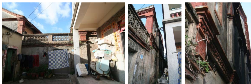
照片二 左側面院門主入口 裝飾特寫
