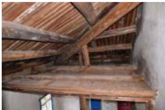
照片 4-296 右後房屋架與半樓
