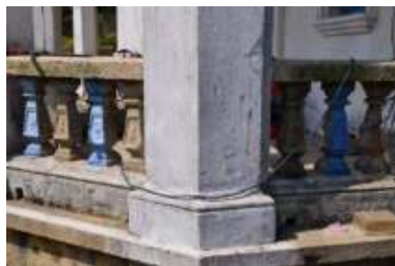
照片 4-108 前廊 RC 立柱柱腳
