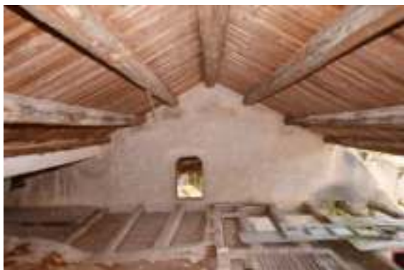
照片 4-299 大廳上方屋架及右中檔壁、木樓板
