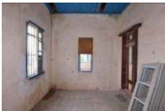
照片 4- 258 左前房前側壁體與左右牆體現況
