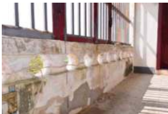
照片 4-230 二樓外廊欄杆欄檻
