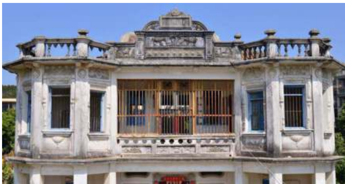
照片 4- 117 董允耀洋樓二樓立面
