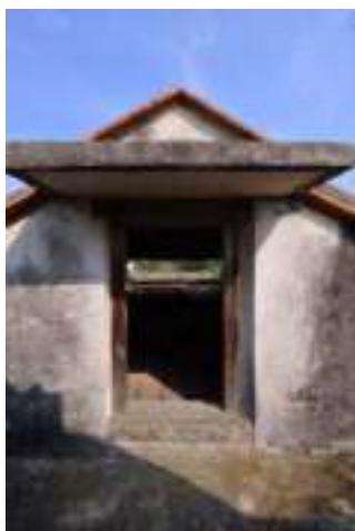
照片 4-310 山牆面出入口
