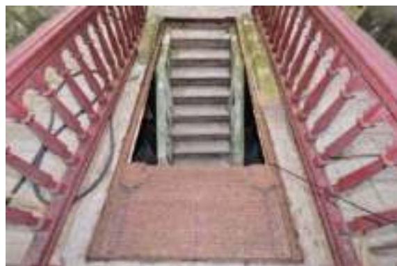
照片 4-246 樓梯與木作欄杆、鑄鐵拉門
