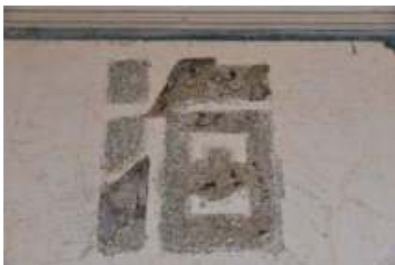
照片 4- 163 洗石子原牆面處理，周邊塗白漆
