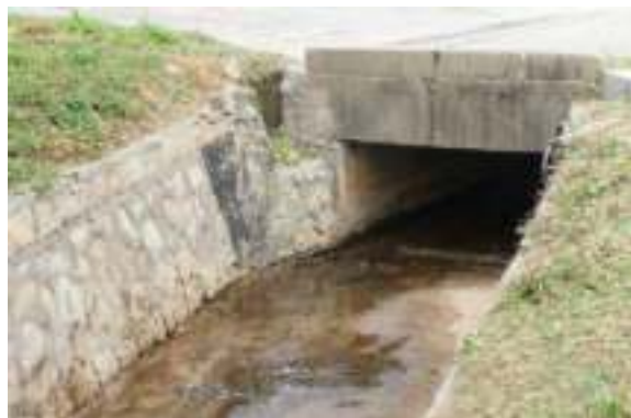
照片 2- 122 珠水路旁的溝渠
