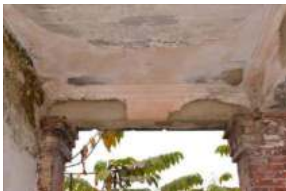
照片 4-472 RC 樑與樓板損壞修補
