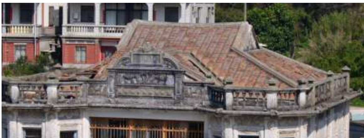
照片 4- 305 董允耀洋樓屋頂
