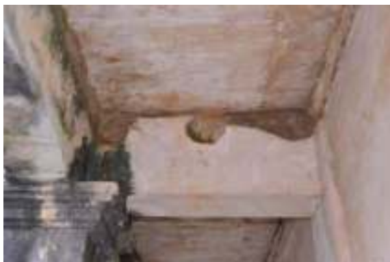
照片 4- 390 左次間上方之 RC 樑有原有孔洞
