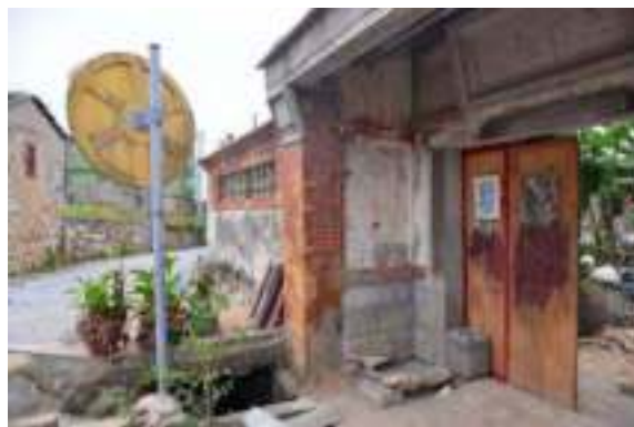
照片 4- 60 門樓大門與右廊牆
