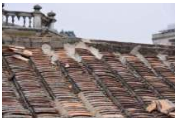
照片 4-488 屋面瓦片破損修補
