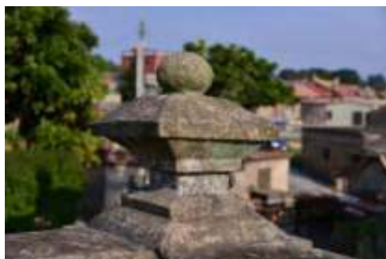
照片 4-417 女兒牆望柱柱頂裝飾
