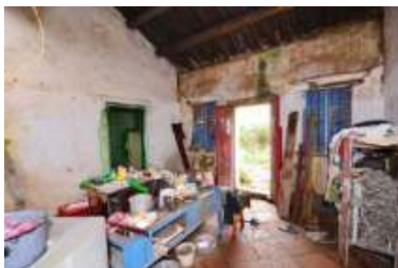
照片 4-476 明間內部
