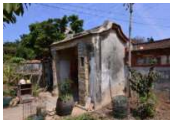
照片 4- 56 門樓內側現況
