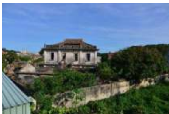
照片 4- 38 洋樓後側與圍牆
