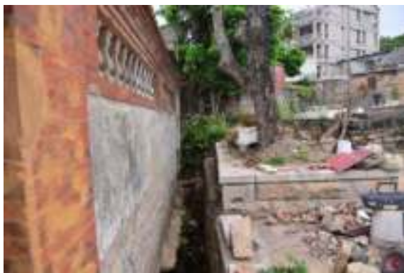
照片 4-41 門樓左側圍牆與水溝
