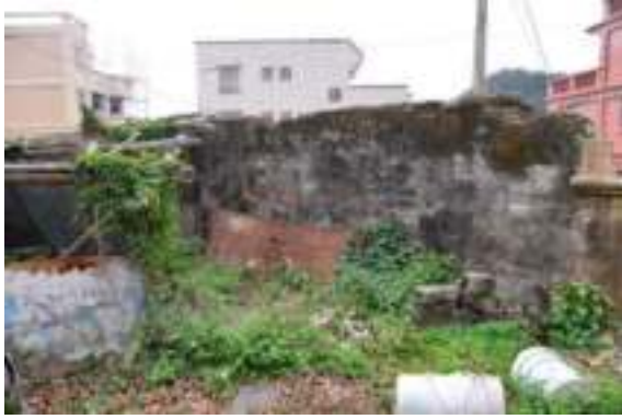
照片 4- 503 左側即利用圍牆共構為牆體
