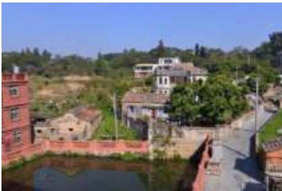
照片 4-29 洋樓前側全景
