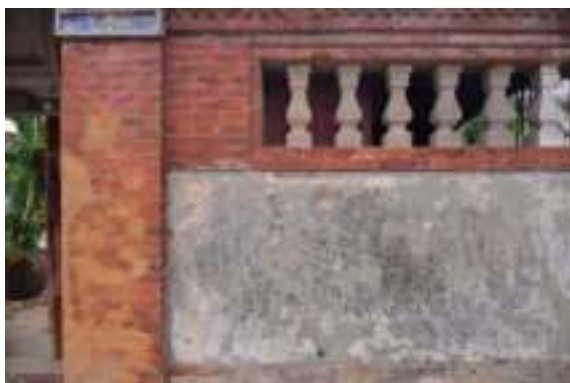
照片 4-43 門樓旁圍牆灰壁牆身與花瓶欄杆
