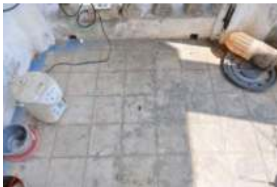
照片 4-170 一樓右次間之水泥幾何地坪
