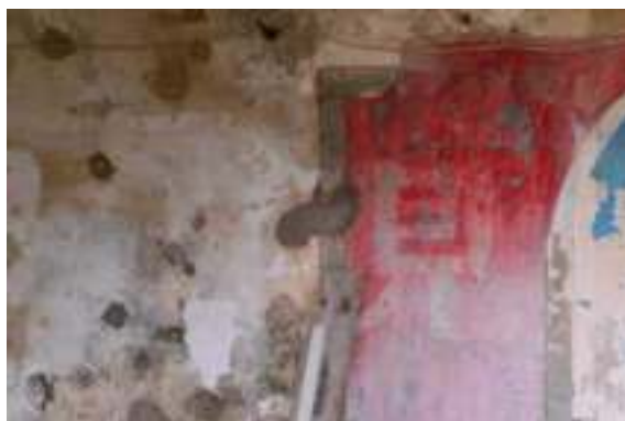
照片 4-474 明間牆體破損修補
