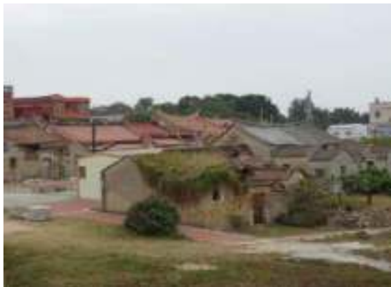
照片 4-11 董允耀洋樓左前方周邊的傳統建築群
