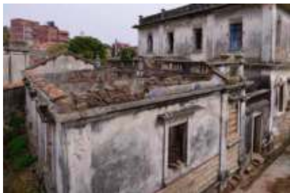
照片 4- 331 後棟全貌
