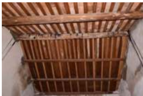
照片 4-599 右房前坡改用桷木鐵皮屋頂
