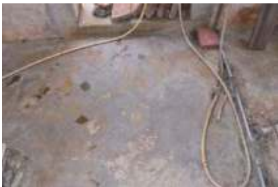
照片 4- 386 明間地坪現況
