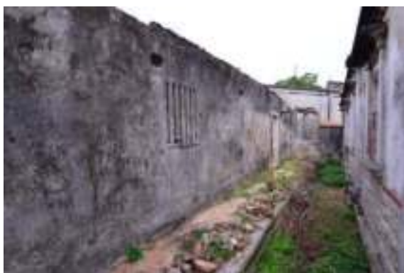
照片 4-491 後房正面牆體磚牆抹灰
