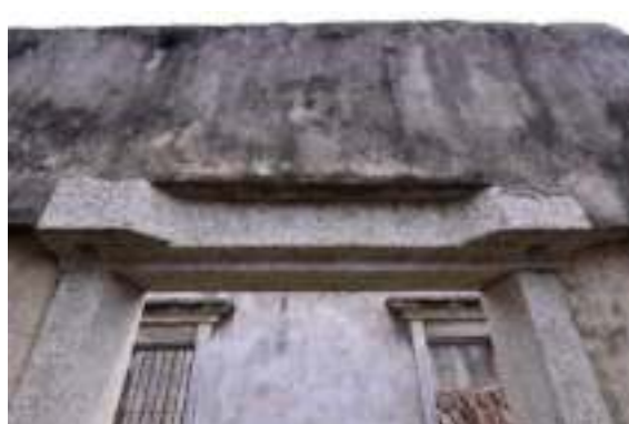
照片 4-494 石作門框良好門扇佚失
