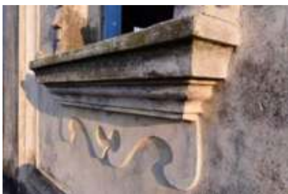
照片 4-140 二樓開窗窗臺多層線腳
