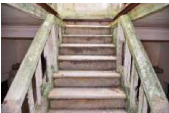
照片 4- 185 RC 樓梯及其上之鑄鐵拉門
