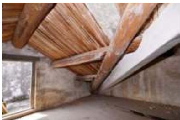
照片 4-298 前坡前側 RC 樑與閣樓
