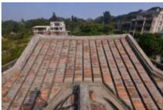
照片 4-314 龜殼式屋頂前坡與交叉脊、天溝
