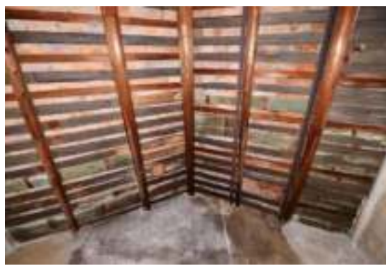
照片 4-597 左房屋架以工字型鋼樑輔助
