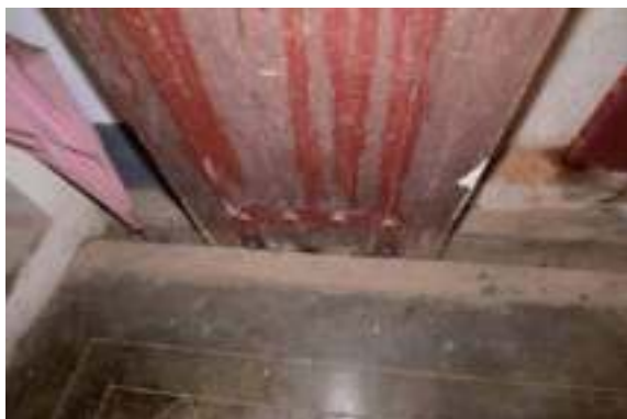
照片 4- 179 輪錢門之凹槽與門板
