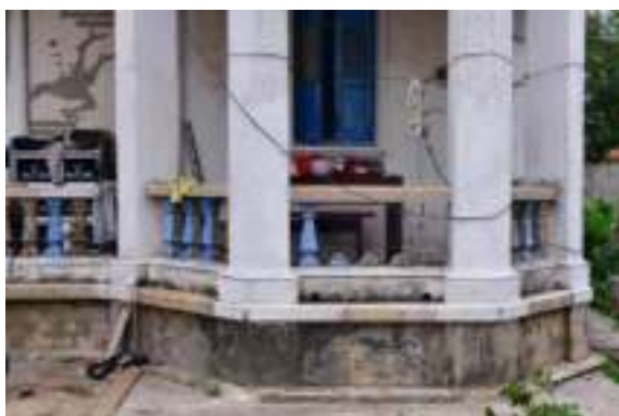
照片 4-103 左側前廊臺基、RC 立柱與欄杆
