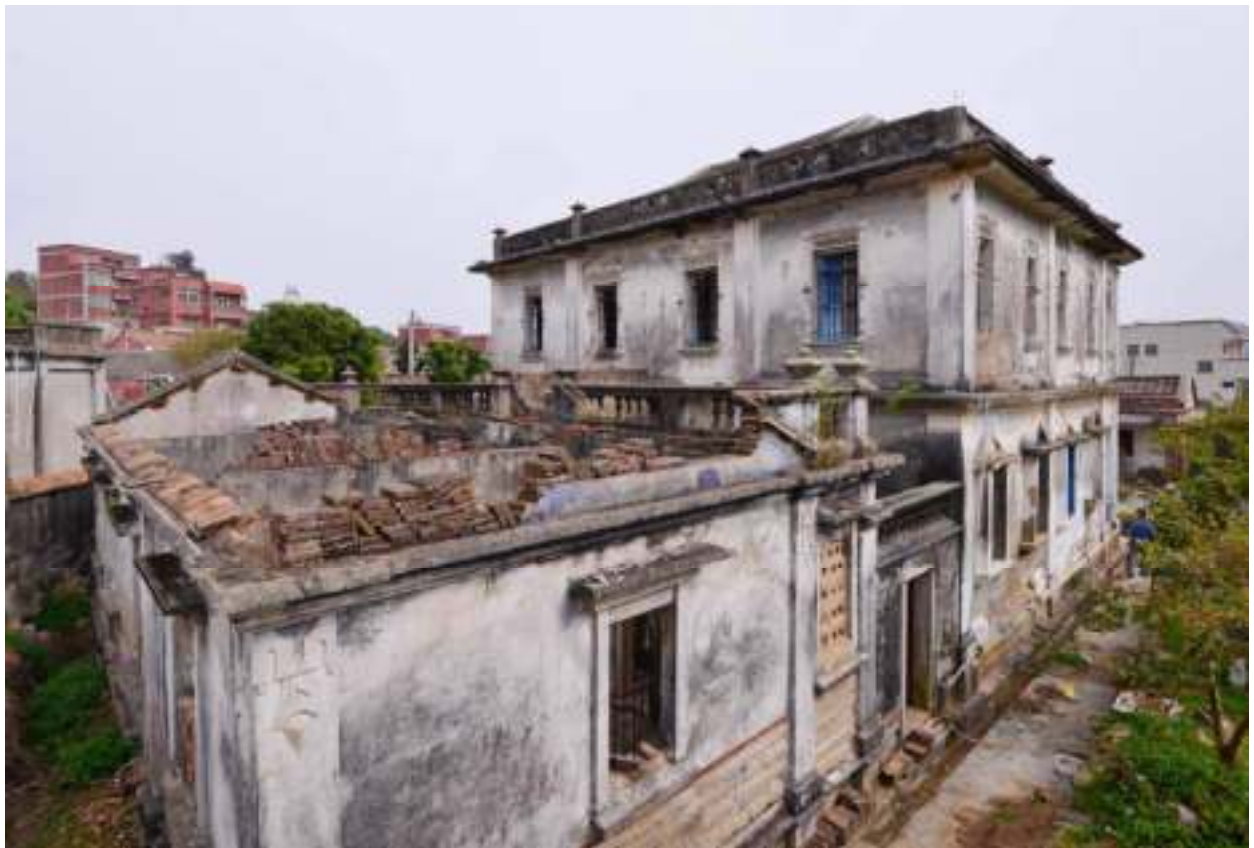
董允耀洋樓後側全貌
