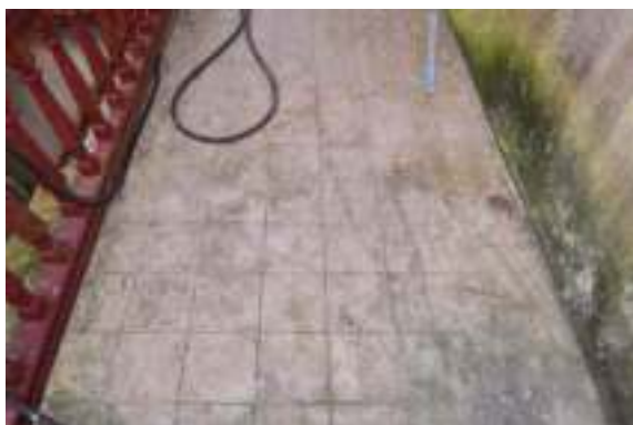
照片 4-245 梯間左右地坪為水泥鋪面
