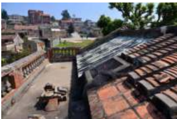
照片 4-463 前廊坪頂與傳統仰合瓦屋頂
