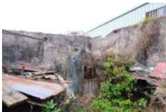
照片 4-498 內部空間左側
