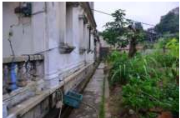
照片 4- 80 洋樓左側與庭院
