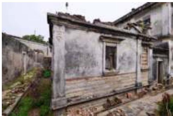
照片 4- 335 後棟右大規壁
