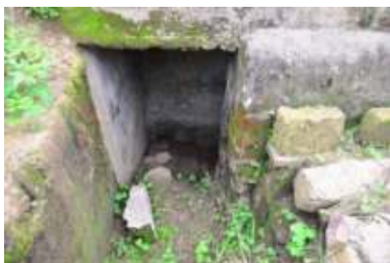
照片 4- 525 防空洞入口
