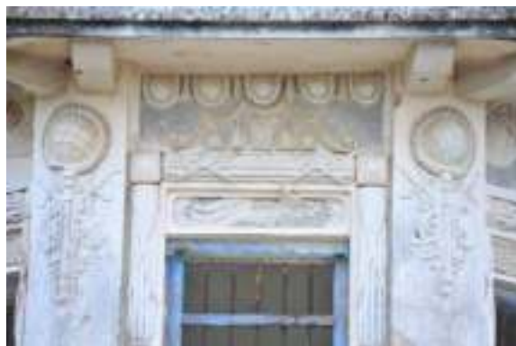
照片 4- 547 柱子頂部水平裂縫
