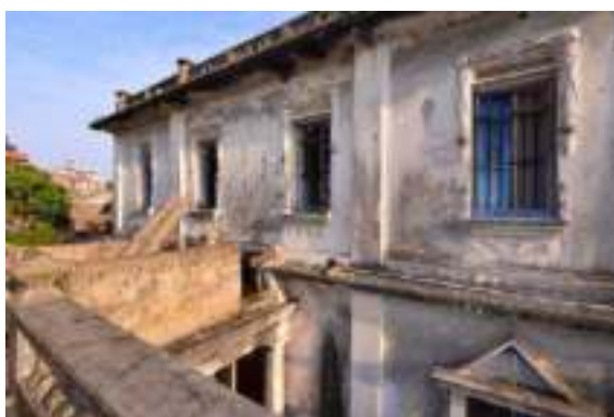
照片 4-130 主棟後側立面與牆體開窗
