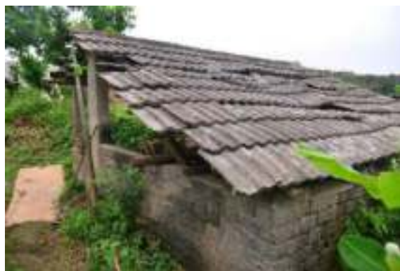
照片 4- 530 水泥瓦屋頂與空心磚牆
