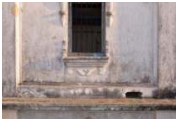
照片 4-148 後寮牆二樓壁體鑿孔洩水
