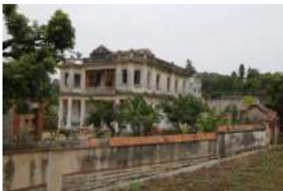
照片 4- 19 洋樓整體環境
