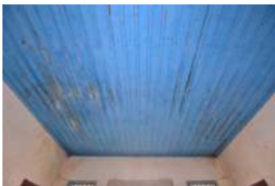
照片 4- 570 二樓明間之拼合天花板
