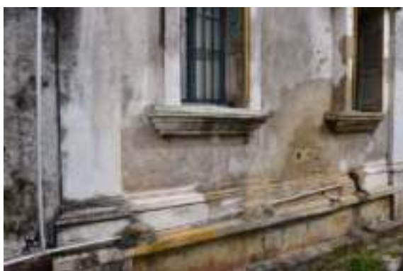
照片 4-156 一樓右後房窗臺及壁體損壞修補
