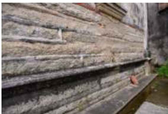
照片 4- 336 後棟大規壁牆基
