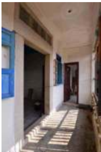
照片 4- 213 二樓外廊
