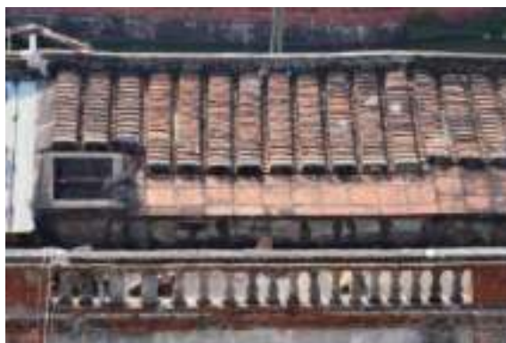
照片 4- 460 迴向屋頂
