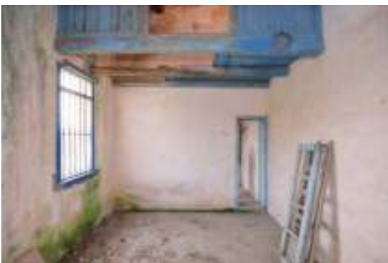
照片 4- 562 二樓之木作半樓
