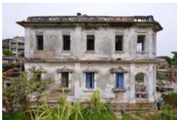
照片 4-129 洋樓主棟右側立面與牆體
