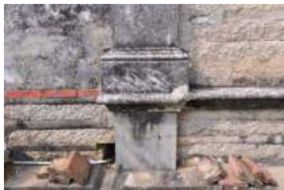
照片 4- 341 立柱柱腳與牆基
