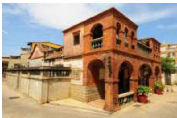
照片 2- 42 許允選洋樓右側外觀立面
