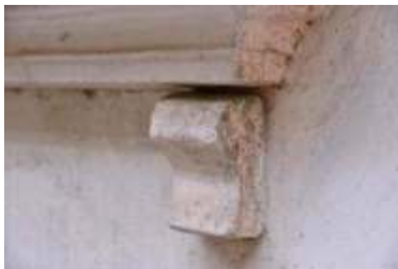
照片 4-138 一樓窗臺下方之泥塑
