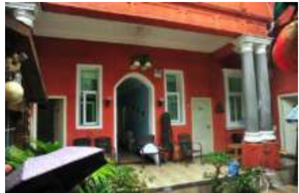
照片 3-23 洋樓現況
