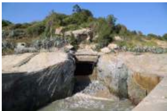
照片 2- 147 大帽山坑道出海口（一）
