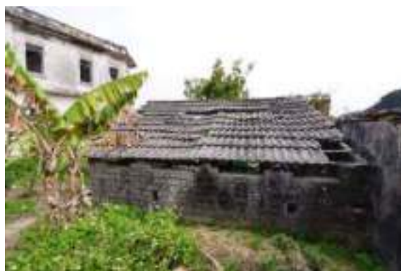
照片 4- 528 背側之水泥瓦與空心磚牆
