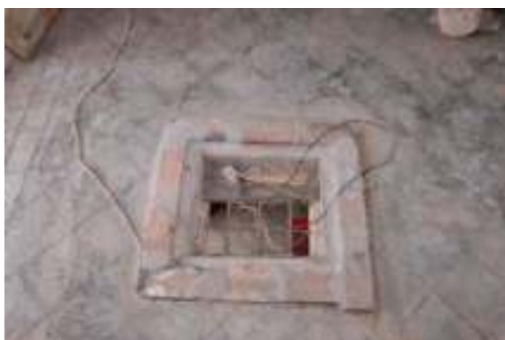
照片 4- 251 大廳地坪中央之監視開口
