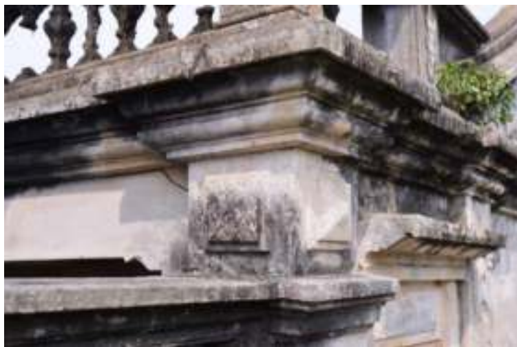
照片 4- 343 廊柱柱頂柱身攢尖泥塑裝飾及檐口線腳
