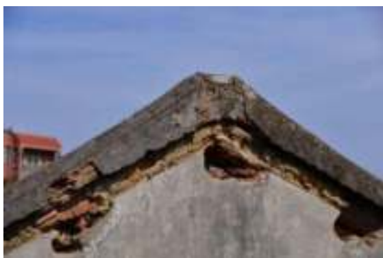
照片 4-414 左大規壁與原楹仔孔洞
