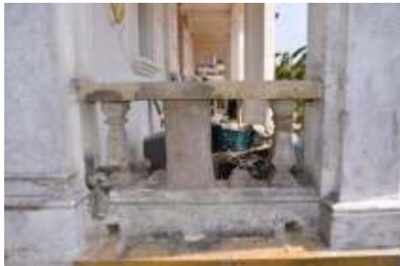
照片 4- 123 右拱圈花瓶欄杆以磚柱替代
