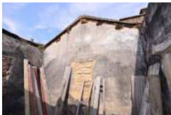
照片 4-406 左房左大規壁左窗封閉
