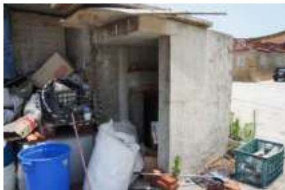
照片 2- 72 編號 7，位於大古崗 35 號左側
