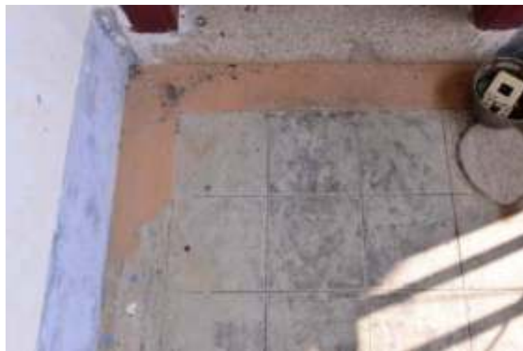
照片 4- 214 外廊水泥地坪
