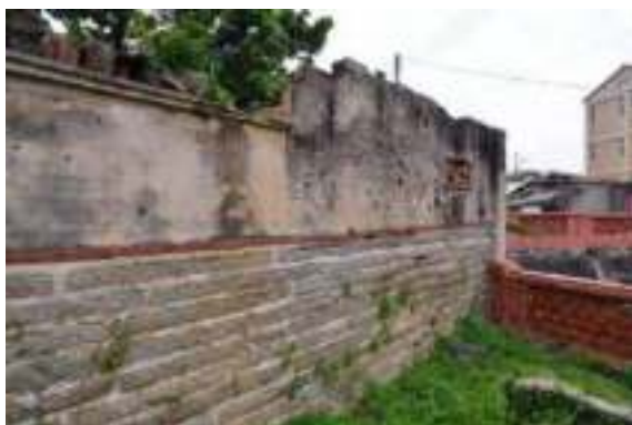
照片 4-48 右側圍牆牆基石寮達 190cm 高
