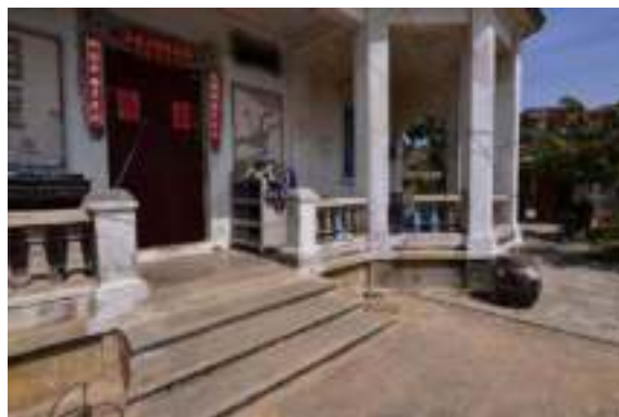
照片 4-102 塌岫與前廊
