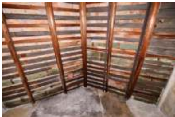
照片 4-481 左房屋架改作並以工字鋼樑補強
