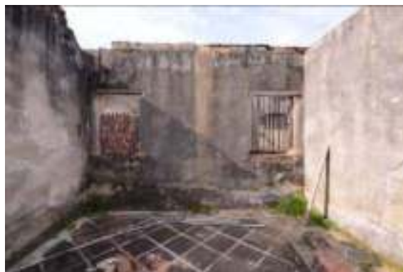
照片 4-403 後棟明間
