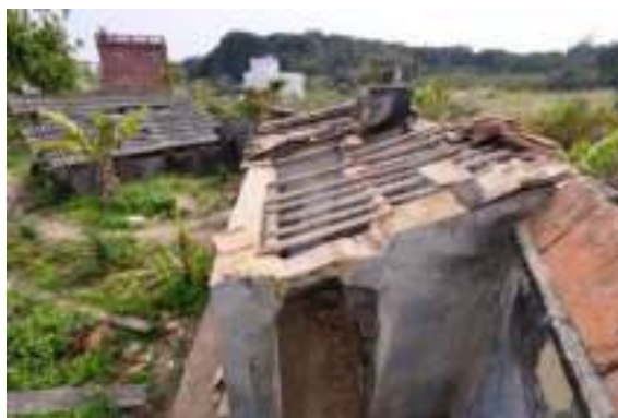
照片 4- 512 屋頂為傳統作法，整修中
