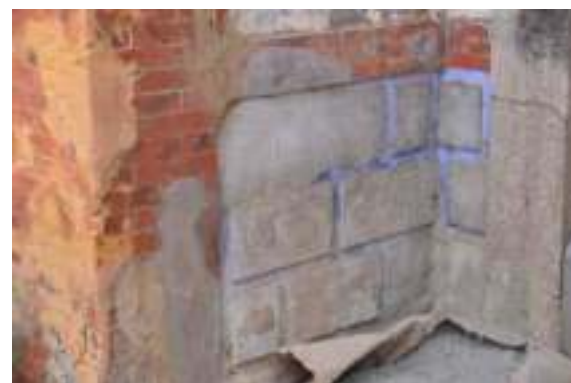
照片 4- 64 牆基為仿石洗石子作
