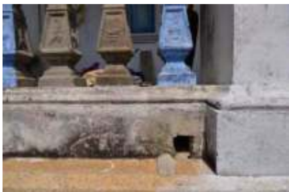
照片 4- 124 右次間欄檻破損修補
