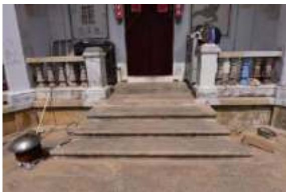
照片 4-105 明間花崗石作弧形臺階
