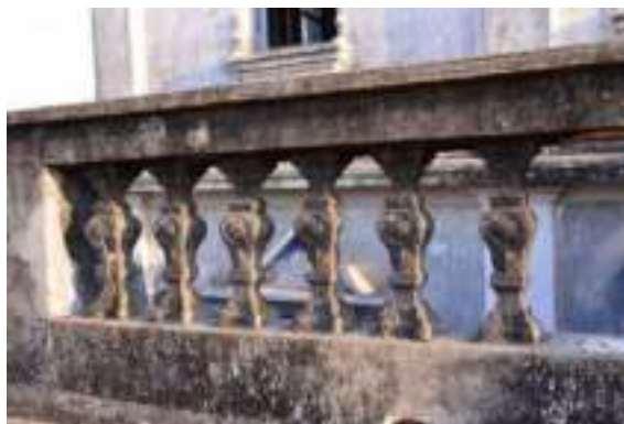
照片 3- 58 後落女兒牆花瓶欄杆
