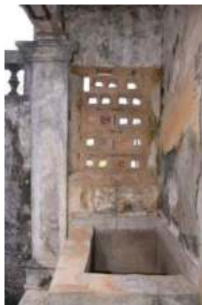
照片 4- 385 右廊牆與封閉之窗戶、水池
