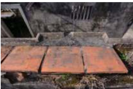
照片 4-416 檐口尺磚與柱頭上方洩水凹槽
