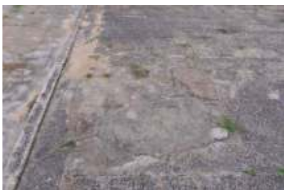
照片 4- 95 明間石作地坪破損以水泥修補
