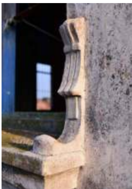
照片 4-141 二樓開窗之兩側泥塑裝飾
