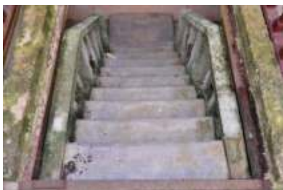
照片 4- 186 鑄鐵拉門滑軌與樓梯
