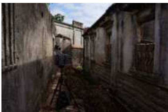
照片 6-91 建築背面掃瞄作業執行
