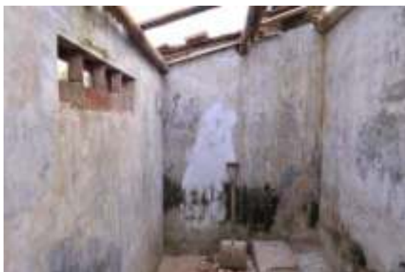
照片 4- 511 廁所內部牆身與屋頂
