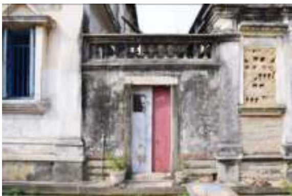
照片 4- 332 深井側牆體立面外觀
