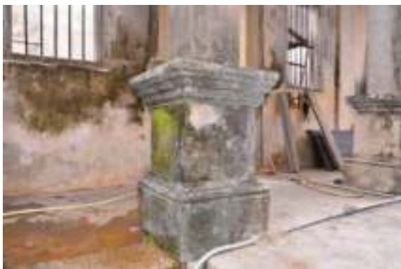
照片 4- 388 明間右側柱基現況
