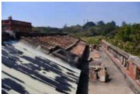
照片 4-462 前廊坪頂及右房屋頂改鐵皮
