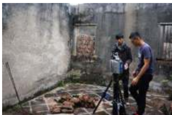
照片 6- 100 後落空間掃瞄作業
