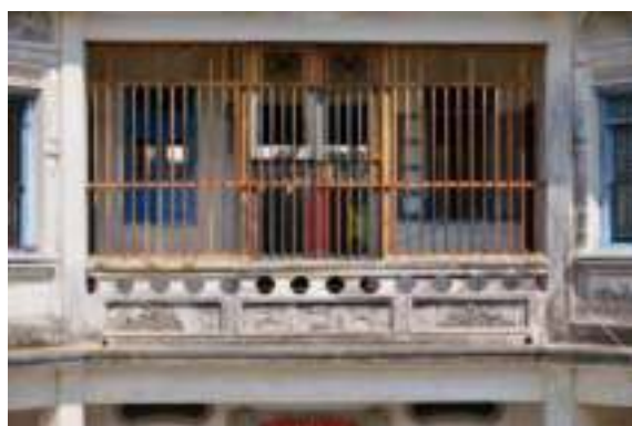
照片 4- 112 三塌岫明間二樓鑄鐵窗
