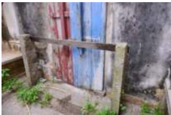
照片 4-376 左側門栓杆與花崗石立柱
