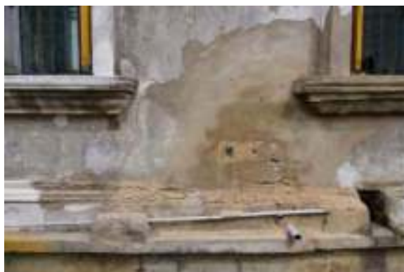
照片 4- 548 牆體表面修補痕跡
