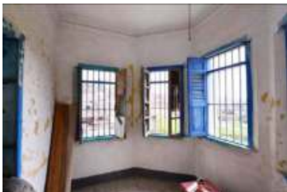
照片 4- 221 左塌岫房及開窗
