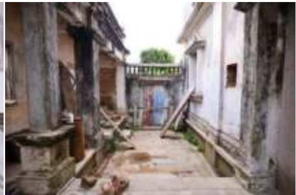
照片 4- 361 左深井與側門
