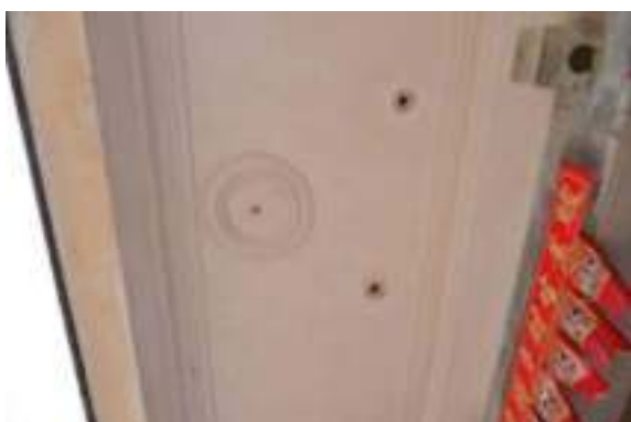
照片 4-171 一樓外廊明間上方天花樓板
