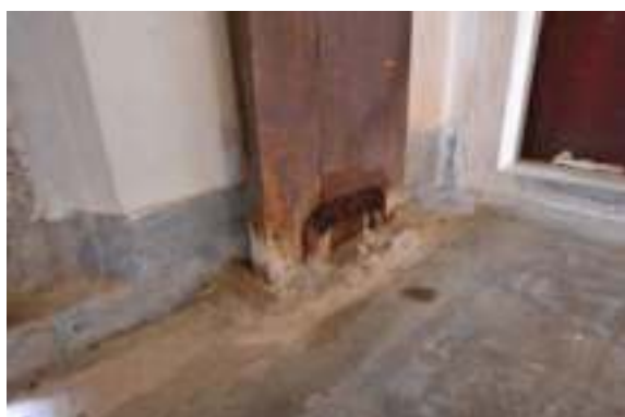
照片 4-189 後輪錢門之門槽及水泥作地坪
