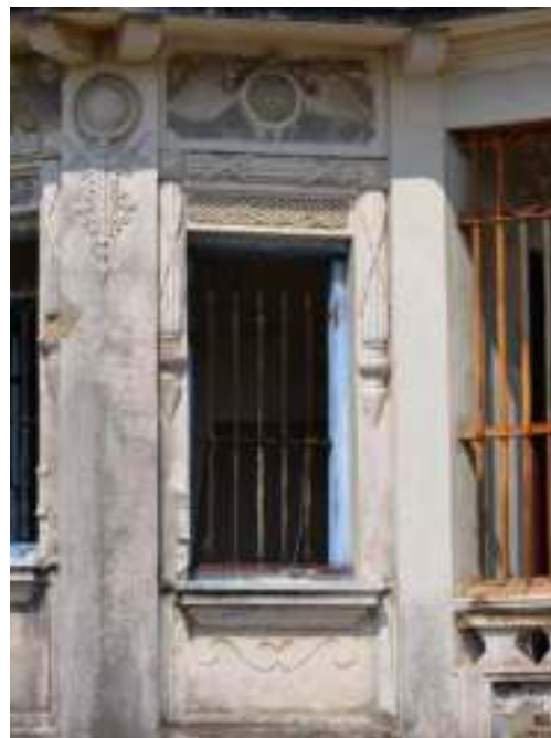
照片 4- 116 左次間側面洋式窗簾狀泥塑與開窗
