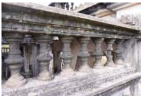
照片 3- 60 深井側門上方女兒牆花瓶欄杆
