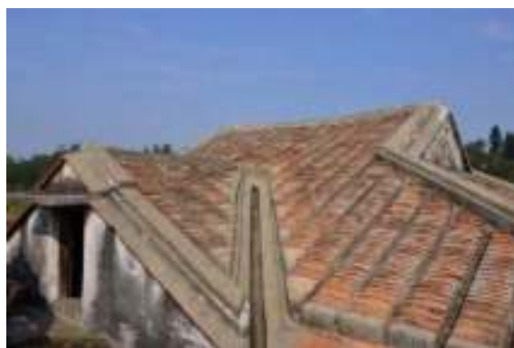
照片 4- 307 龜殼式屋頂及交叉屋頂
