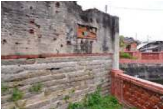
照片 4- 505 牆體外之圍牆牆基及磚作牆身
