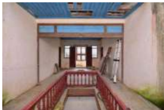
照片 4-244 梯間及壽屏背側
