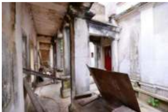
照片 4- 380 後棟前廊
