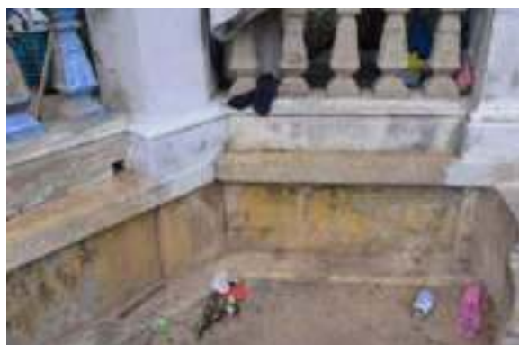
照片 4-104 臺基與柱礎欄杆
