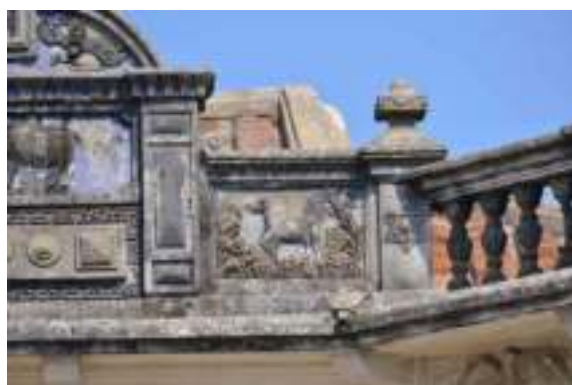
照片 4- 118 洋樓山頭左側泥塑與女兒牆欄杆
