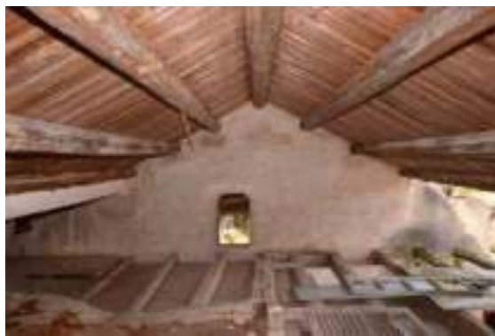
照片 4- 563 明間閣樓木樓板與屋架
