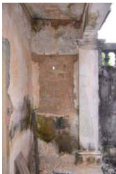
照片 4- 384 左廊牆與封閉之窗戶
