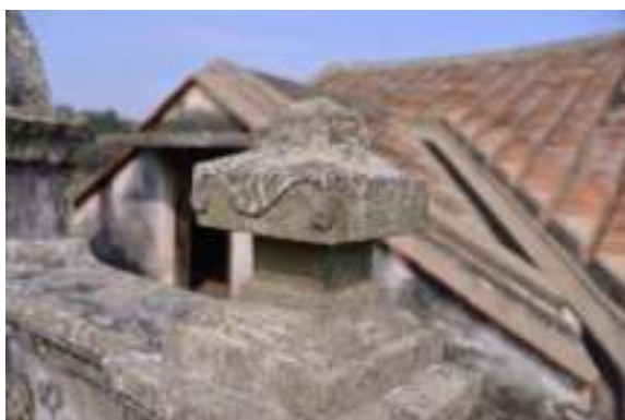
照片 4-312 女兒牆望柱柱頂泥塑
