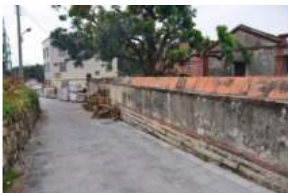
照片 4- 33 洋樓左側道路與圍牆
