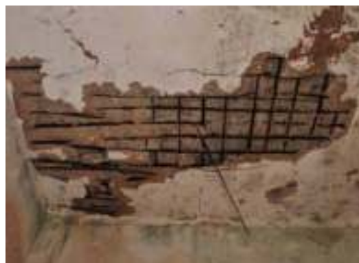
照片 3- 38 陳清吉洋樓之直交鋪設鋼筋
