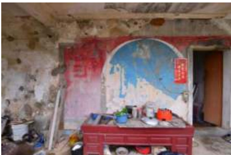
照片 4-429 明間牆體左右開門，右門封閉
