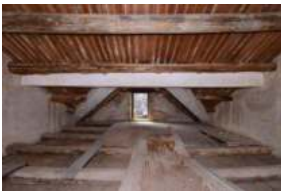
照片 4- 565 前坡之 RC 樑與木楹仔、樓板
