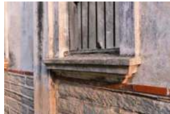
照片 4- 349 後棟窗臺
