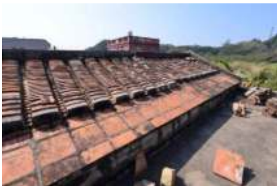
照片 4-461 屋頂瓦壟及端部尺磚收邊
