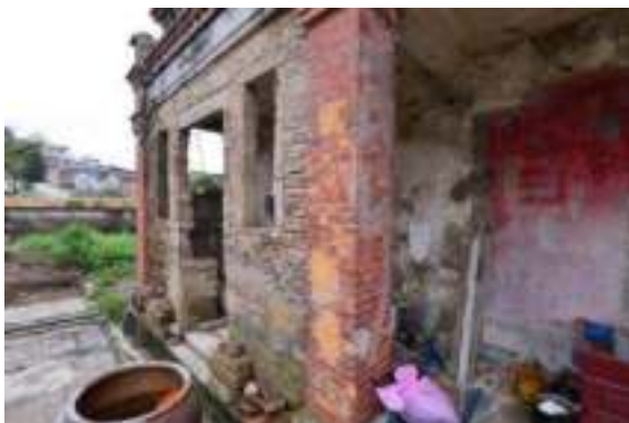
照片 4-469 前廊右前砌築牆體
