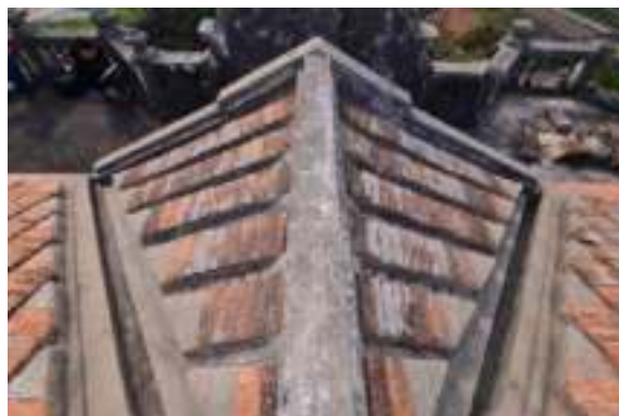
照片 4- 327 前坡交叉屋脊之正脊與兩側天溝
