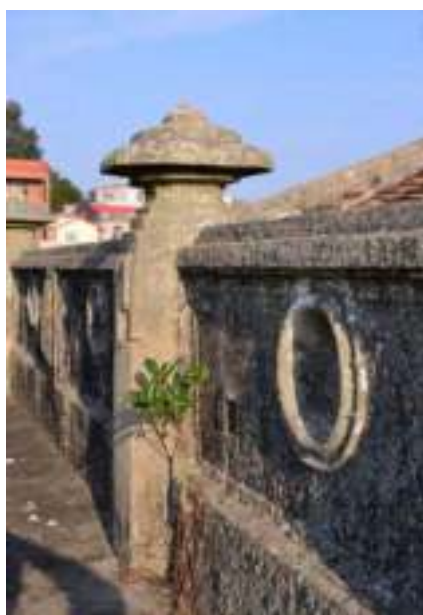
照片 4-142 女兒牆望柱與柱頂、欄板
