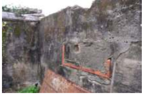
照片 4- 504 原左側之開口與抹灰牆體
