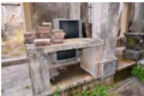
照片 4- 392 右側前廊之後期作 RC、磚柱平臺
