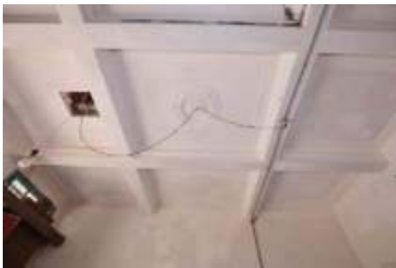
照片 3-43 董允耀洋樓 RC 樓板完好
