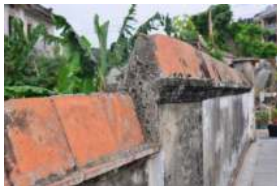
照片 4-47 牆頂斜砌尺磚
