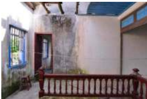
照片 4-247 梯間左側牆體與天花現況
