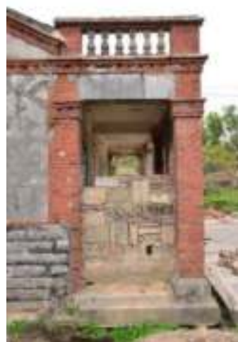
照片 4-430 前廊右側立面
