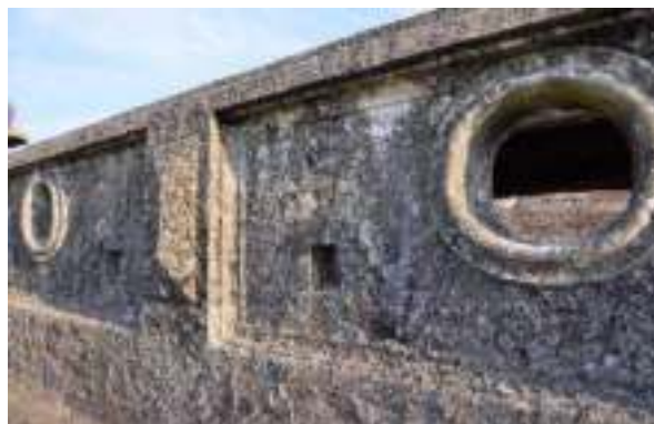
照片 4-144 女兒牆欄板與圓洞、間柱
