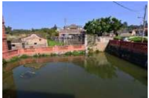
照片 4-30 洋樓前方水池與圍牆
