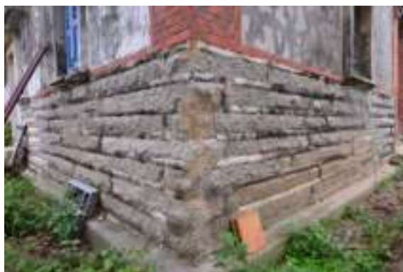
照片 4-482 礫仔石溝縫修補混亂
