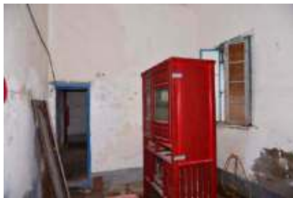
照片 4- 202 右後房現況
