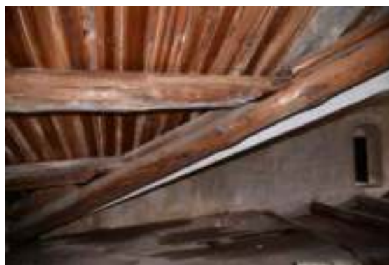
照片 4-589 交叉屋頂右斜梁與屋架木構件
