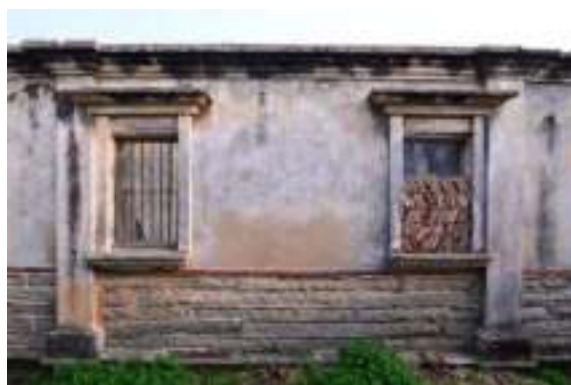
照片 4- 345 後棟後寮牆明間開二窗
