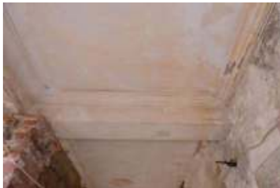
照片 4-432 前廊 RC 樑與樓板
