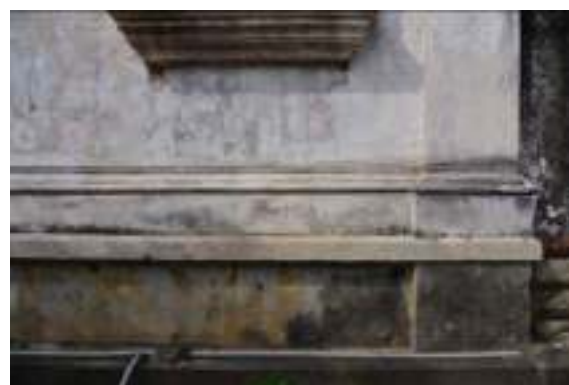
照片 4-131 主棟臺基與立柱柱腳、牆基
