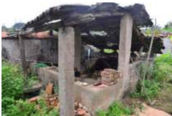
照片 4- 529 RC 立柱與簡易屋架
