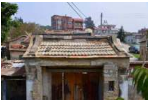
照片 4- 59 門樓後坡屋面改為水泥瓦
