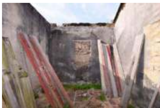
照片 4-405 左房現況後窗封閉
