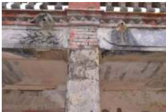
照片 4-470 明間左前立柱改為 RC 柱
