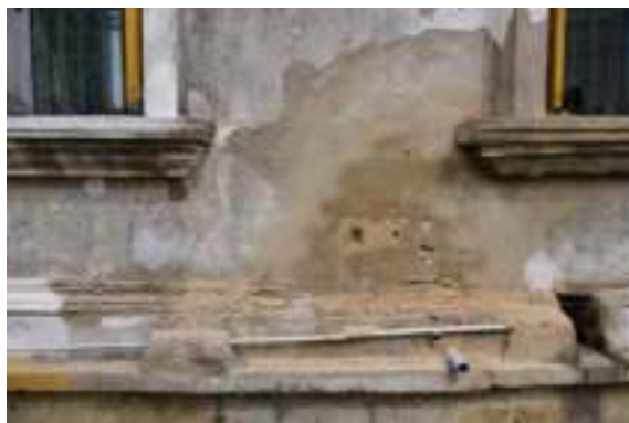
照片 4-154 一樓右後房窗臺下壁體損壞修補
