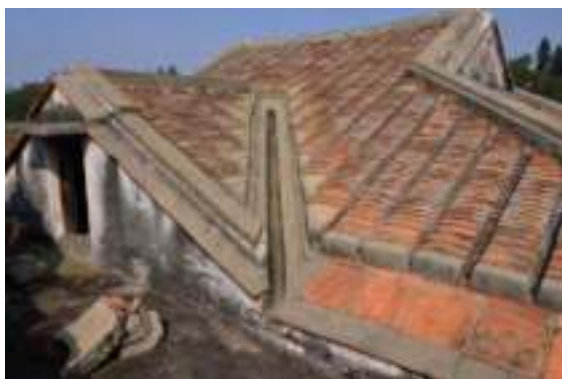
照片 4-558 前棟龜殼式屋頂與交叉屋頂
