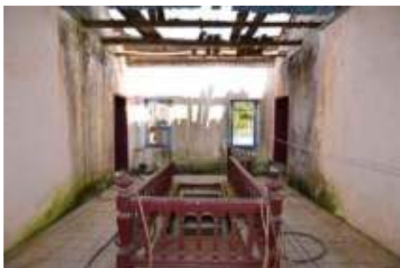
照片 4-243 梯間現況
