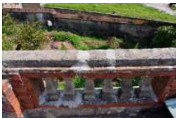
照片 4-487 女兒牆扶手破損修補
