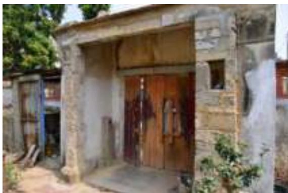
照片 4-73 門樓後側增建之空間磚立柱
