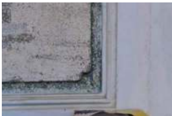
照片 4- 164 原牆身之泥塑線腳與洗石子裝飾
