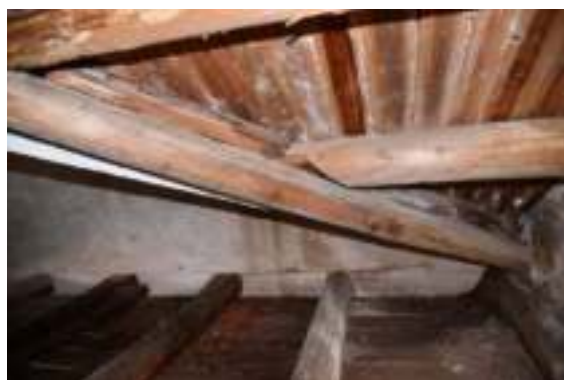
照片 4-588 交叉屋頂左斜梁與屋架木構件
