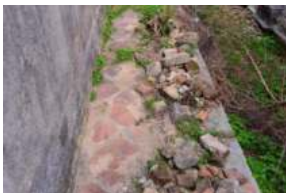
照片 4-496 檐口為斜鋪尺磚
