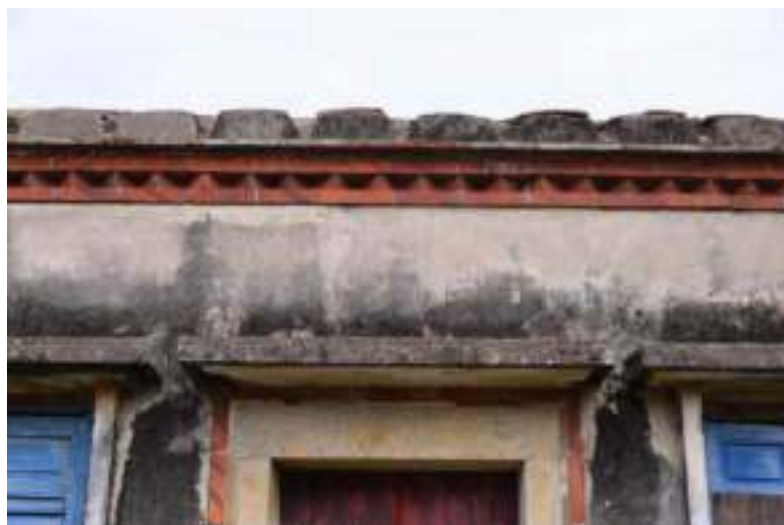
照片 4- 444 後門石作門框及雨庇、檐口磚作線腳
