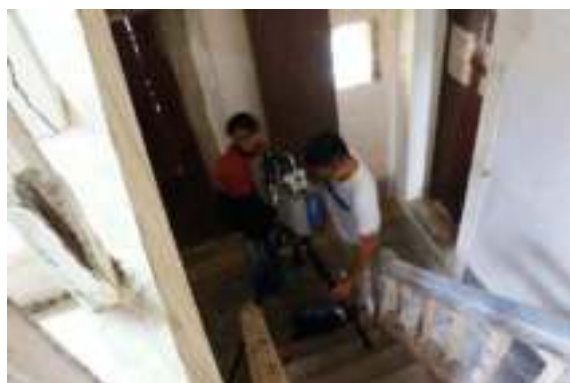
照片 6-94 一、二樓掃瞄測站銜接作業
