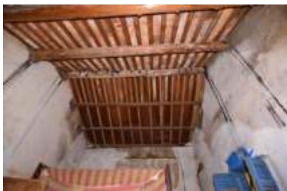
照片 4-456 右房前坡屋架改為楠仔替代
