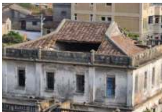
照片 4- 306 洋樓前棟屋頂背側
