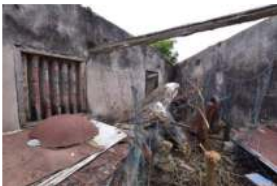
照片 4-497 內部空間右側
