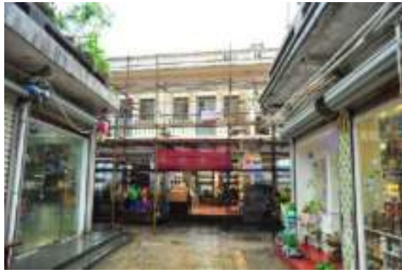
照片 3-20 海壇路二層樓店屋情況（一）
