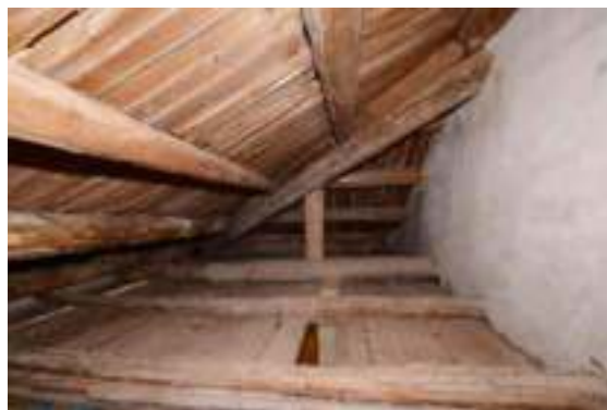
照片 4- 569 龜殼屋頂之兩側屋架與天花樓板
