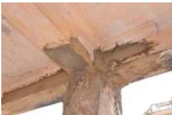
照片 4-471 RC 樑損壞修補
