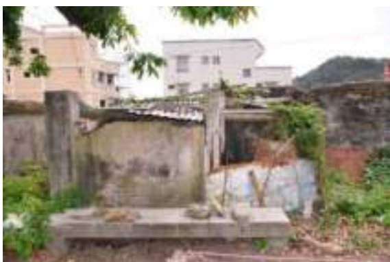
照片 4- 501 以二支 RC 立柱為立面之結構
