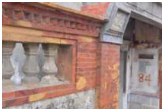
照片 4-44 門樓旁磚柱及花瓶欄杆
