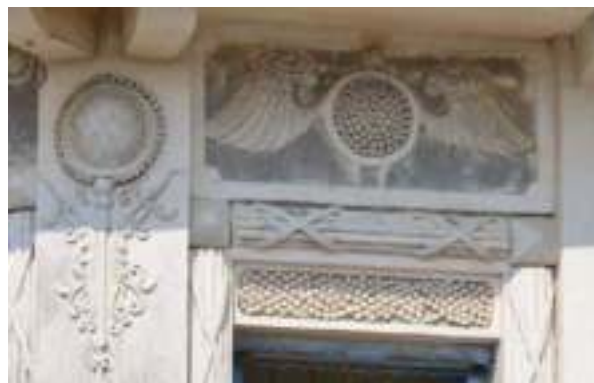
照片 3-52 二樓窗戶窗簾式泥塑及窗楣
