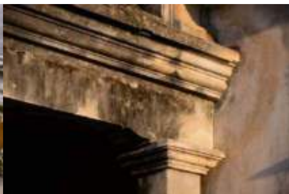
照片 4- 371 前立柱之柱頭與 RC 樑及檐口
