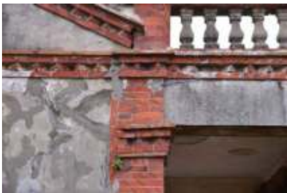
照片 4-483 左大規壁壁面損壞修補
