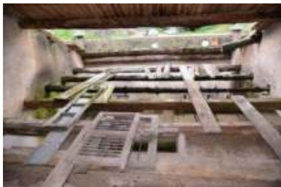
照片 4-300 明間閣樓木樓板現況
