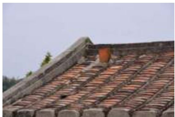
照片 4-467 後坡屋頂原有之煙囪
