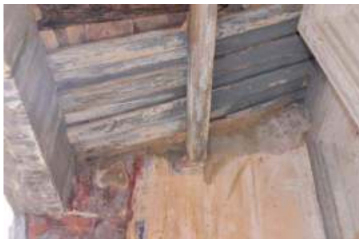
照片 4- 66 前坡屋架
