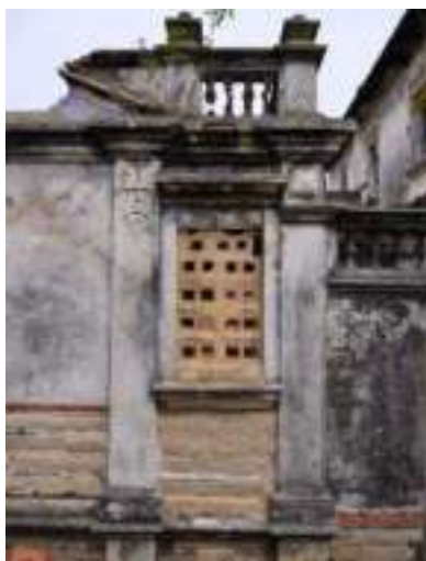
照片 4- 338 後棟廊牆外側
