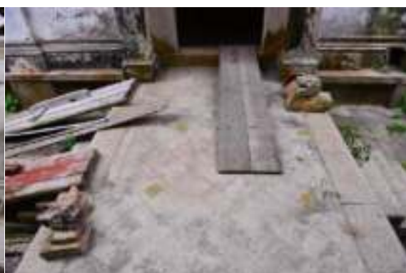
照片 4- 367 過廊中央鋪面為水泥斜鋪分割
