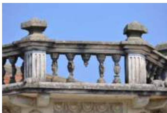
照片 4- 119 洋樓屋頂女兒牆欄杆
