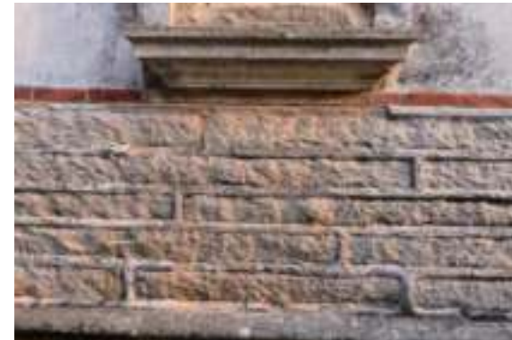
照片 4- 347 後寮牆牆基下堵礫仔石砌築
