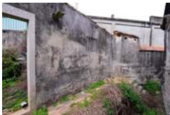
照片 4-492 大門石作門框及左側牆體
