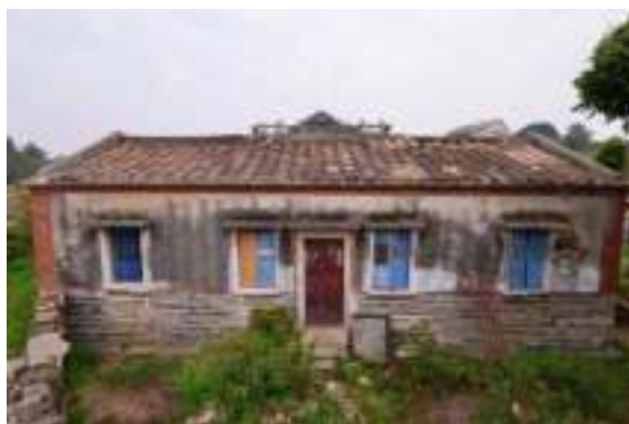
照片 4-466 迴向屋頂後坡
