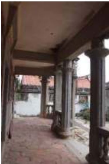
照片 3-67 碧山陳清吉洋樓鋼筋混凝土三塌岫式外廊
