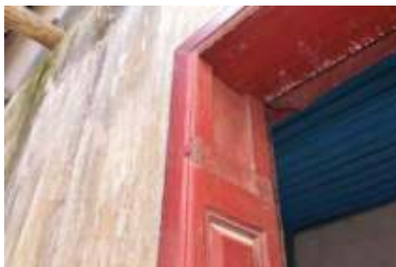
照片 4-292 右後房門框構件被鋸斷
