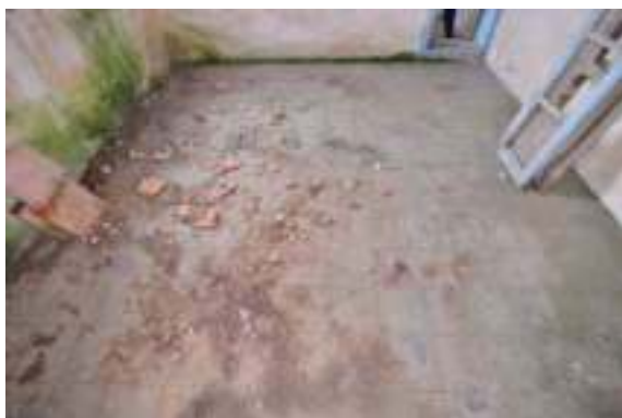
照片 4-267 左後房地坪現況
