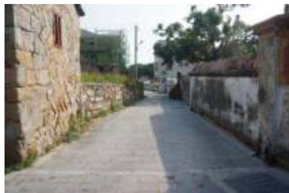
照片 4-6 洋樓左前方巷道
