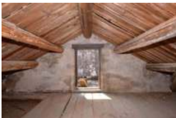
照片 4-297 屋頂前坡下方之閣樓與屋架
