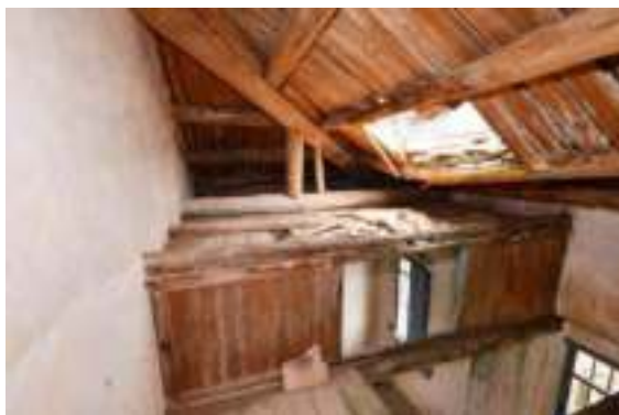
照片 4- 568 左後房上方之屋架與半樓空間
