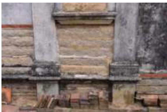
照片 4- 350 右廊牆牆基礫仔石塗灰泥
