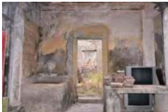
照片 4- 383 右次間立面灰壁及石作大門現況
