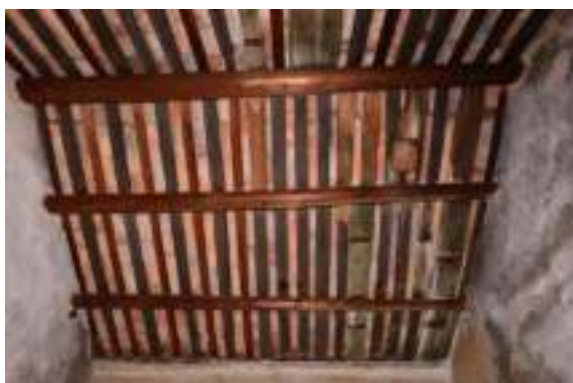
照片 4-596 左房屋架樑仔斷面過小
