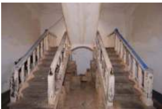
照片 4- 183 梯間之樓梯通二樓
