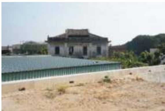
照片 4- 13 洋樓後方鐵皮屋與擋土牆
