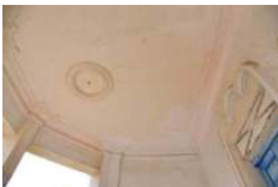
照片 4-172 一樓右次間天花樓板
