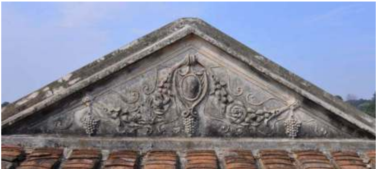
照片 3-46 洋樓屋頂左側山尖泥塑
