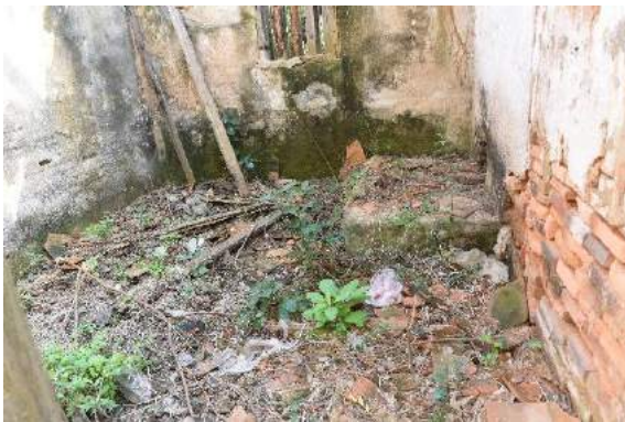
圖 175：後裙房室內現況（2）
