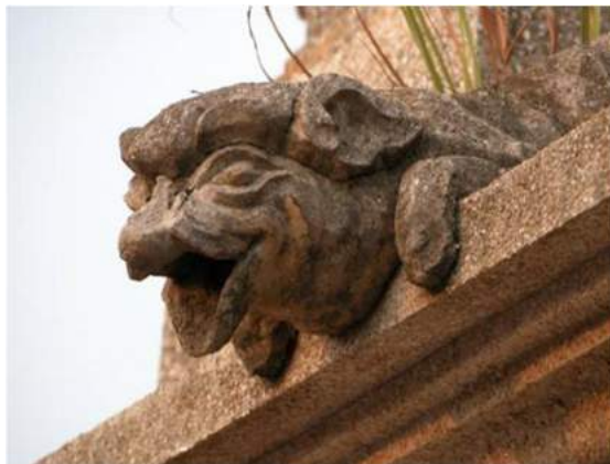
圖 40：豬造型的落水口（水頭黃廷瓢宅第護龍洋樓）
