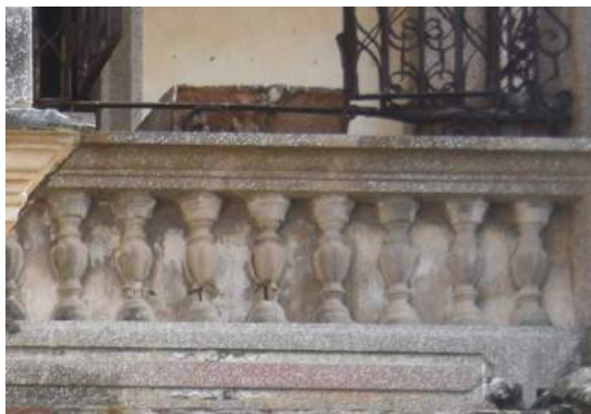
圖 189：王金城洋樓二樓水泥欄杆
