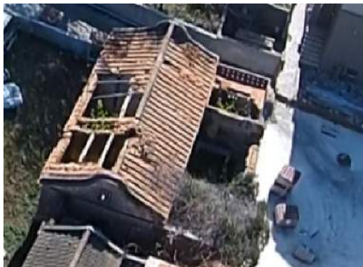
圖 204：一落二擡頭屋頂現況（1）
