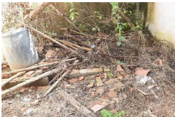
圖 183：一落二擗頭室內現況（4）
