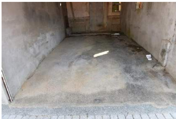
圖 180：一落二擗頭室內現況（1）
