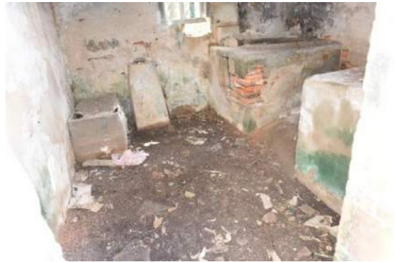
圖 174：後裙房室內現況（1）
