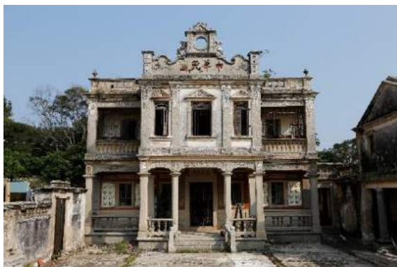
圖 94：洋樓正向立面
