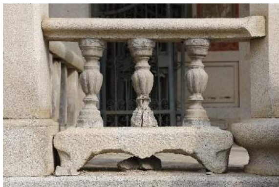
圖 110：一樓花瓶造型欄杆
