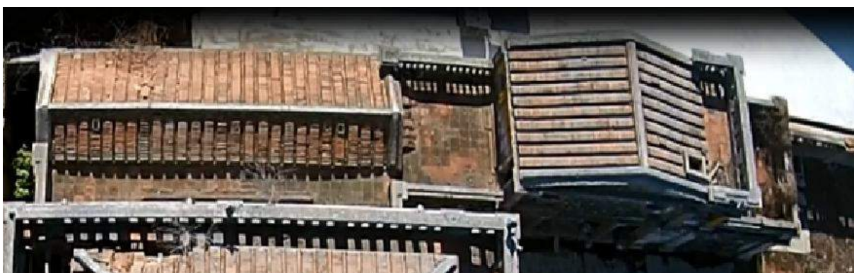
圖 200：左護龍屋頂現況
