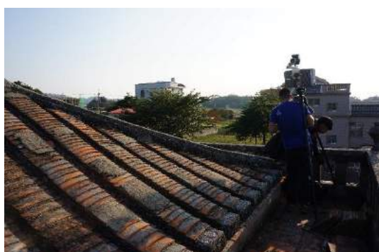
圖 254：主棟建築屋面掃描作業（1）
