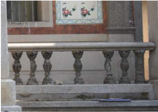
圖 186：王金城洋樓一樓欄杆現況
