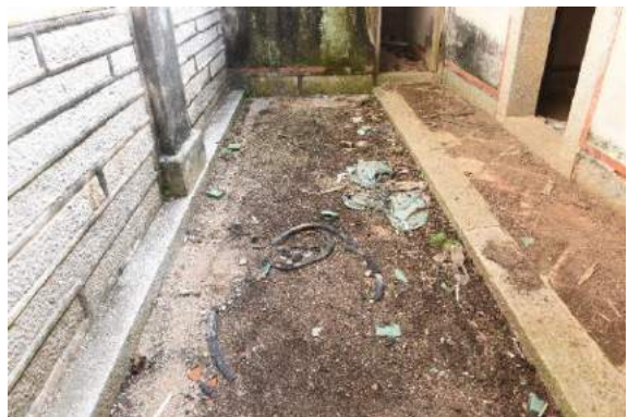
圖 172：左護龍天井現況
