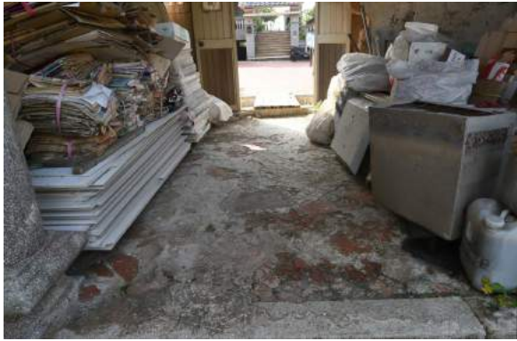
圖 167：左護龍入口處現況
