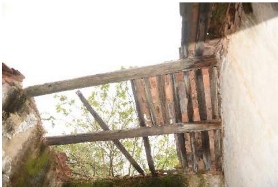
圖 202：後裙房屋頂現況（2）
