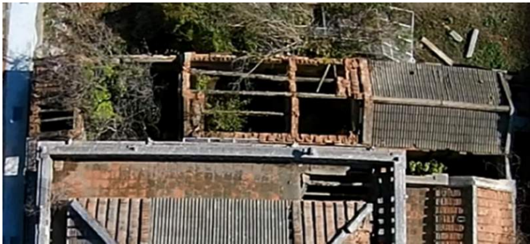
圖 201：後裙房屋頂現況（1）
