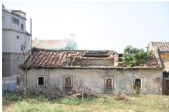
圖 205：一落二擡頭屋頂現況（2）
