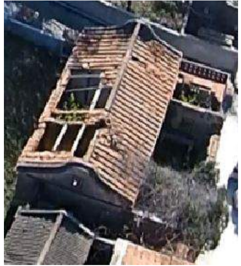
圖 105：屋頂一落二舉頭空拍照
