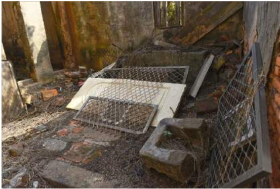
圖 177：後裙房室內現況（4）
