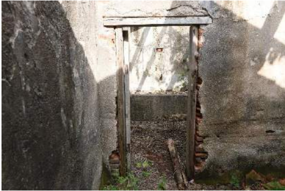
圖 195：後裙房屋身現況
