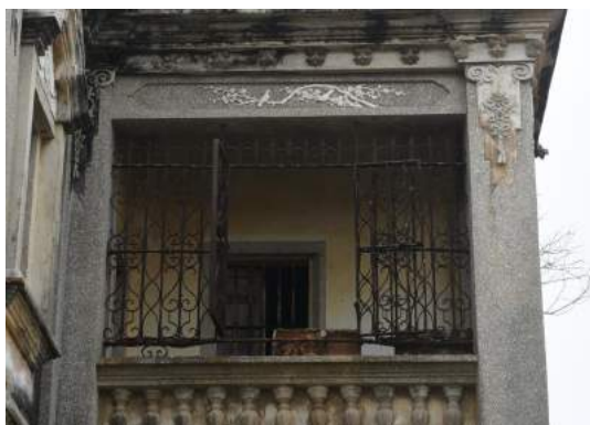
圖 191：王金城洋樓二樓防盜鐵窗
