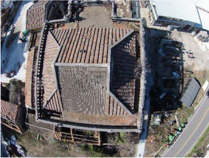
圖 104：王金城洋樓屋頂空拍照
