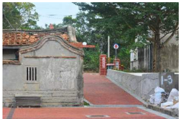
圖 146：位於王金城洋樓旁的后宅聚落入口處
