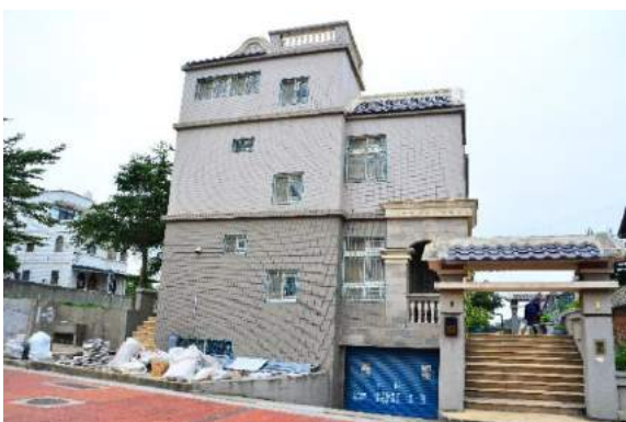
圖 155：左方的 3 樓 RC 樓房
