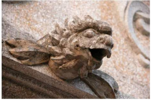
圖 47：鰲魚造型的落水口（水頭黃廷瓢宅第護龍洋樓）
