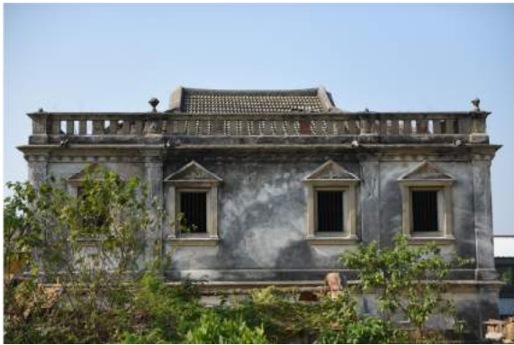
圖 125：王金城洋樓主體之歇山式屋頂
