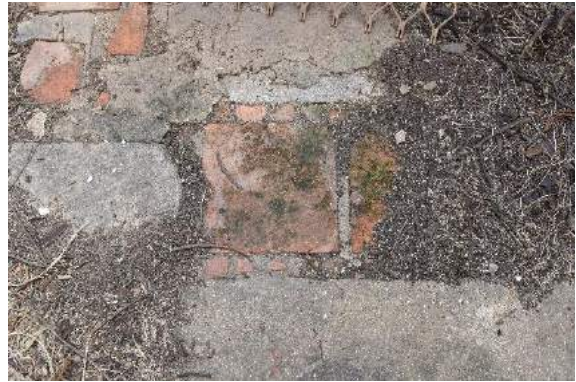
圖 178：後裙房室內鋪面現況
