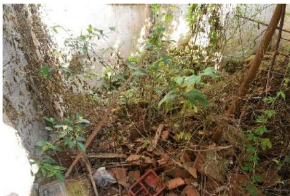
圖 184：一落二擗頭室內現況（5）
