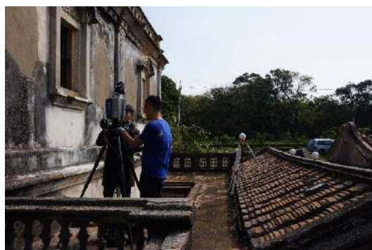
圖 251：左側護龍屋面掃描作業
