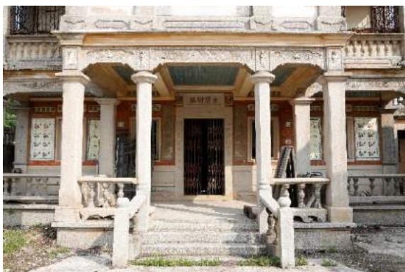
圖 102：出龜一樓入口空間
