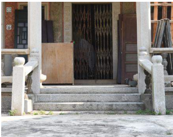
圖 134：外廊臺階部分
