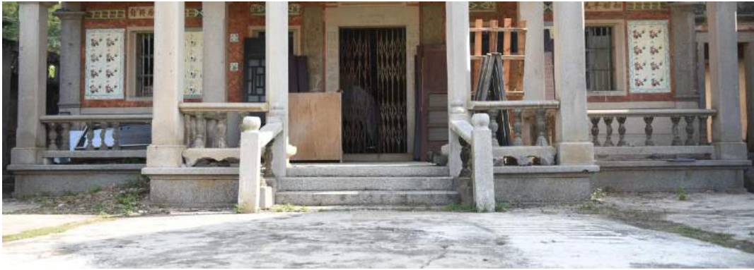
圖 185：王金城洋樓臺基現況
