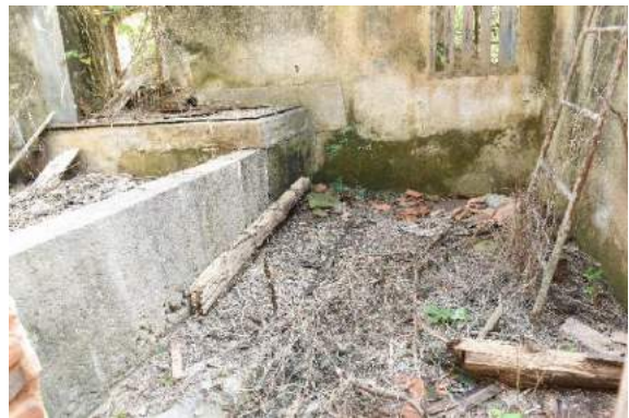
圖 176：後裙房室內現況（3）
