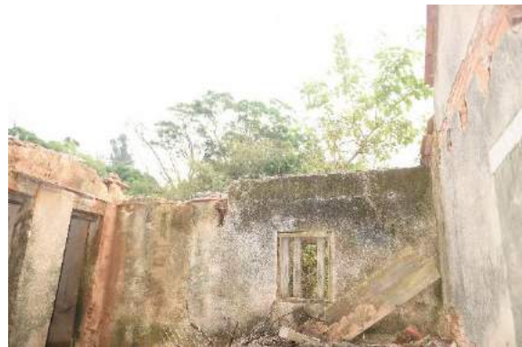
圖 203：後裙房屋頂現況（3）
