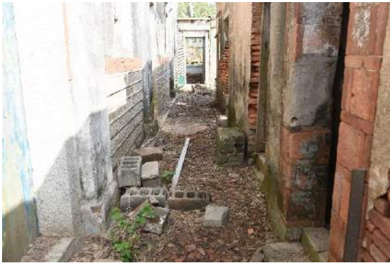
圖 173：後裙房過廊現況
