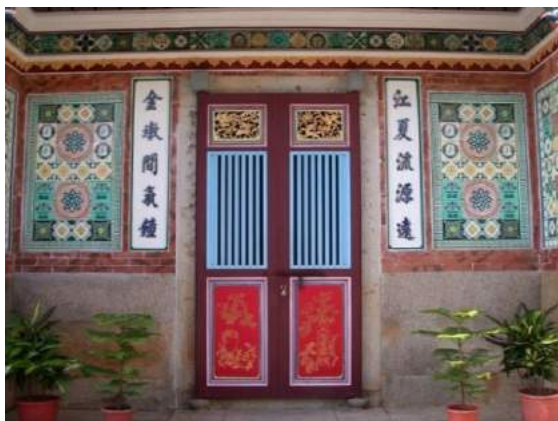
圖 41：水車堵及壁堵上的彩釉磁磚（水頭黃順圖番仔厝）
