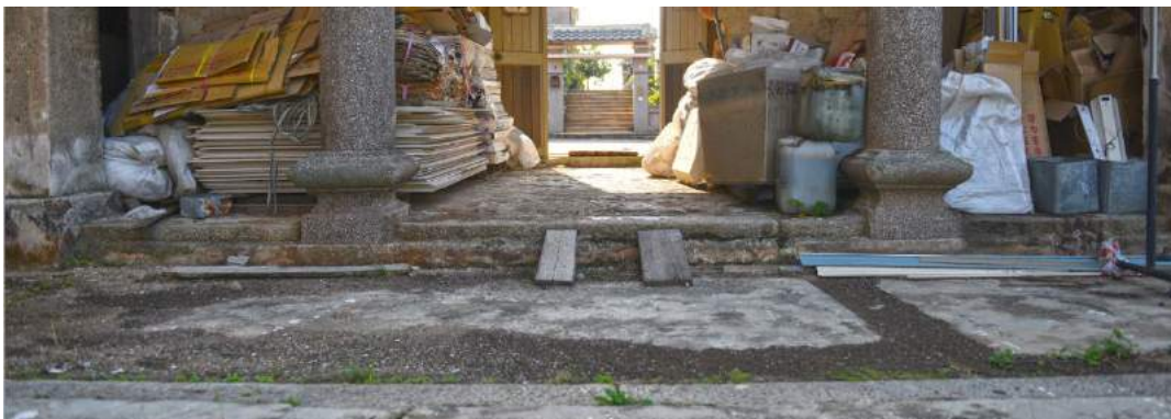
圖 188：左護龍臺基現況
