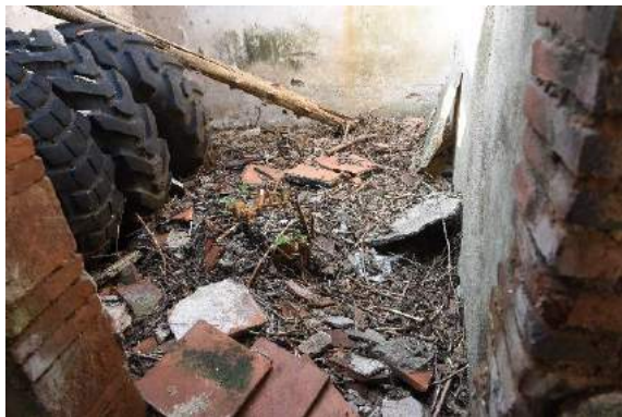
圖 181：一落二擗頭室內現況（2）
