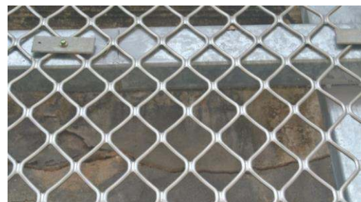
照片 3-3-12：一樓背面亦有水平裂縫
