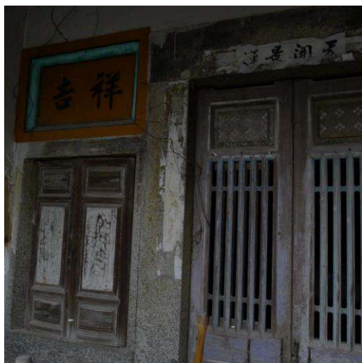
照片 3-4-1：D1 彩繪材料劣化
