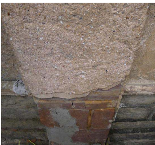
照片 2-3-13：磚造扶壁柱
