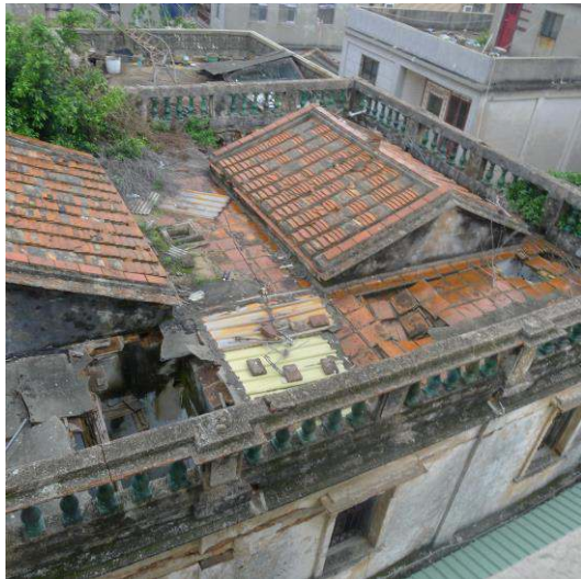
照片 2-3-15：屋頂閩南式屋面
