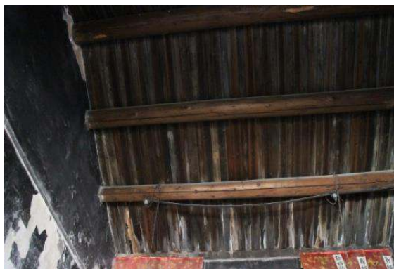
照片 3-3-6：二樓前廳桁木構件
