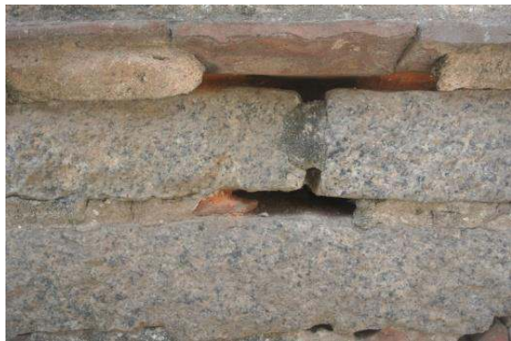
照片 3-3-4：牆體基礎為花崗石材
