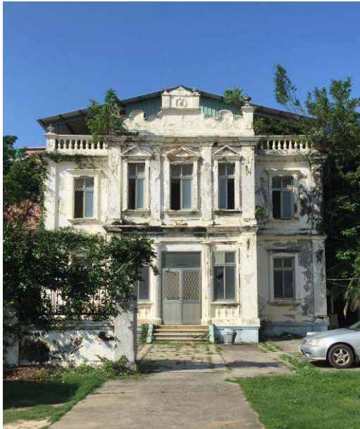
照片 2-3-57：鄧長壽洋樓外廊
