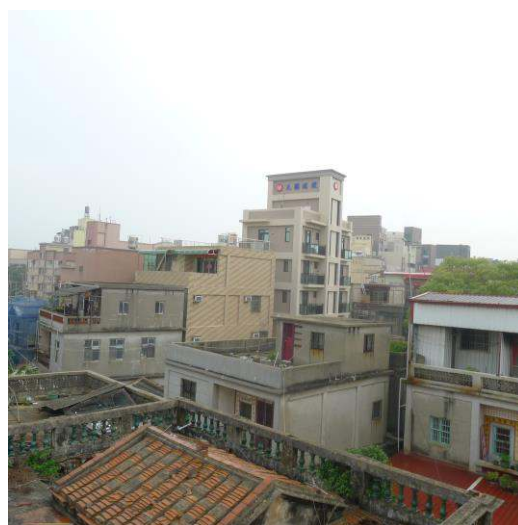
照片 3-1-4：洋樓後方的建築強度分布狀況
