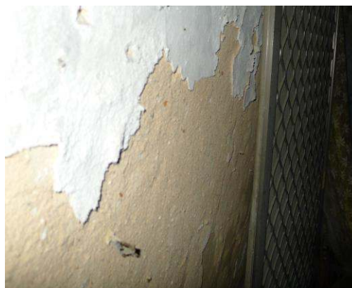
照片 2-5-10：內牆灰作粉刷
