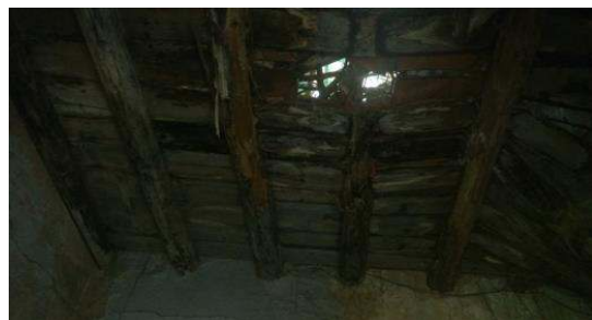
照片 3-3-19：右前房樓板塌陷、桁木斷裂、橡板破損及牆壁出現裂縫
