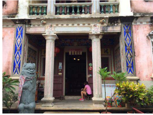
照片 2-3-24：黃永遷兄弟洋樓外廊柱頭
