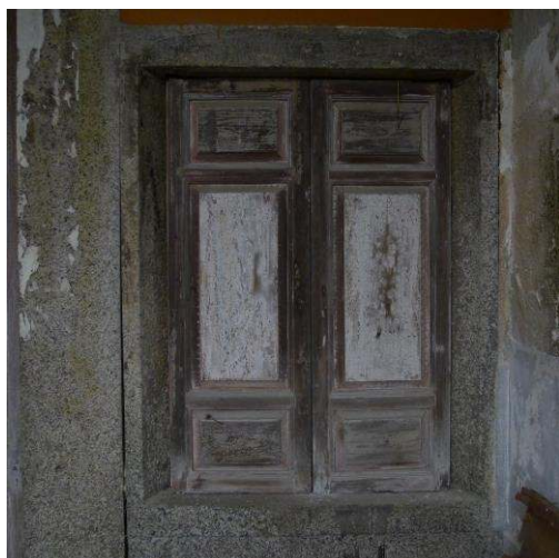
照片 3-4-3：W1 彩繪材料劣化
