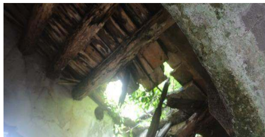
照片 3-3-29：右前房上方屋桁腐朽部分掉落及破損
