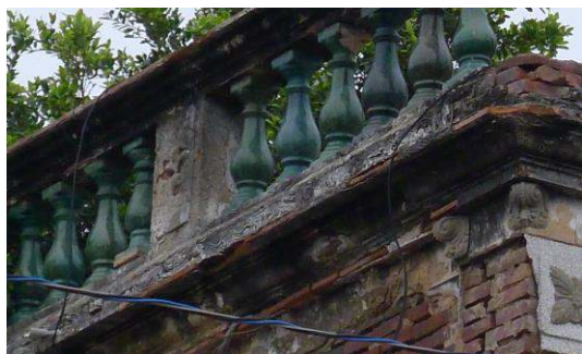
照片 2-5-5：女兒牆與欄杆細部
