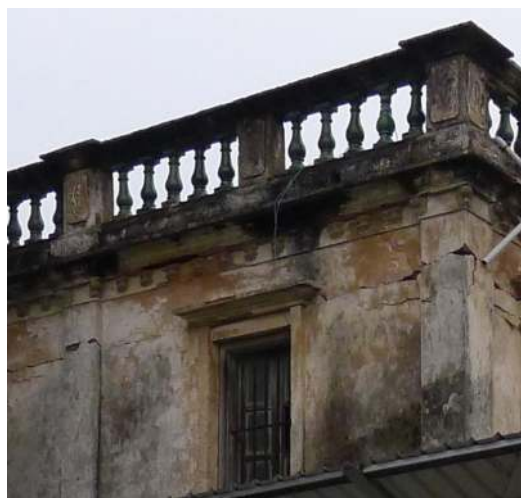
照片 2-3-14：屋頂女兒牆的望柱
