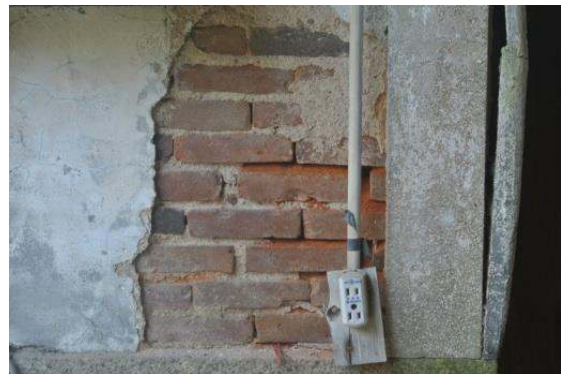
照片 3-3-5：石牆體基礎上方為磚砌構造
