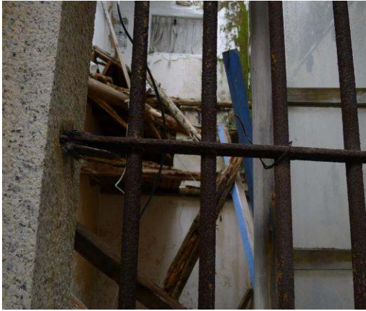
照片 2-3-41：金屬格柵結構鐵件細部
