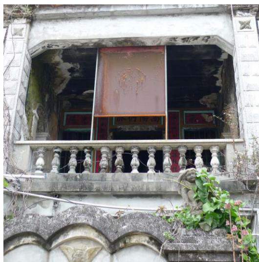
照片 2-4-20：洋樓二樓金屬照壁
