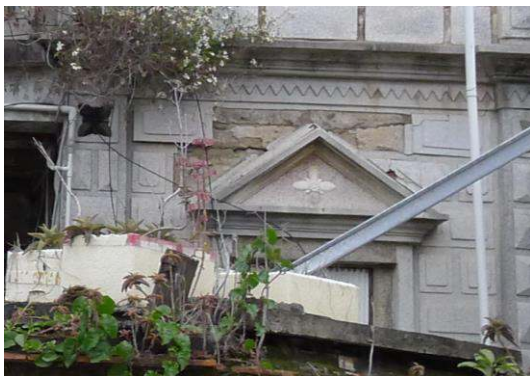
照片 2-3-27：柱頭及中間段水平裝飾帶 裝飾紋樣為後期改建
