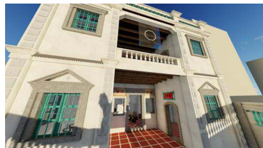
照片 4-2-4：修復後洋樓正立面(白晝)
