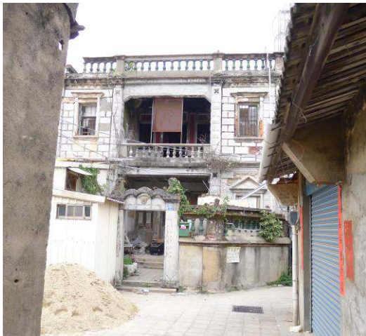
照片 2-3-59：洋樓正面全貌
