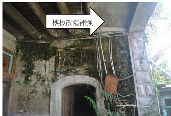
照片 3-3-17：混凝土樓板及樑的修補
