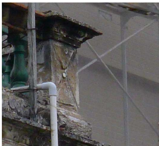
照片 2-3-67：洋樓女兒牆望柱裝飾
