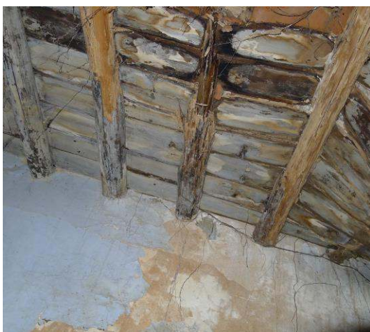
照片 2-5-3：福州杉桁木支撐木作樓板
