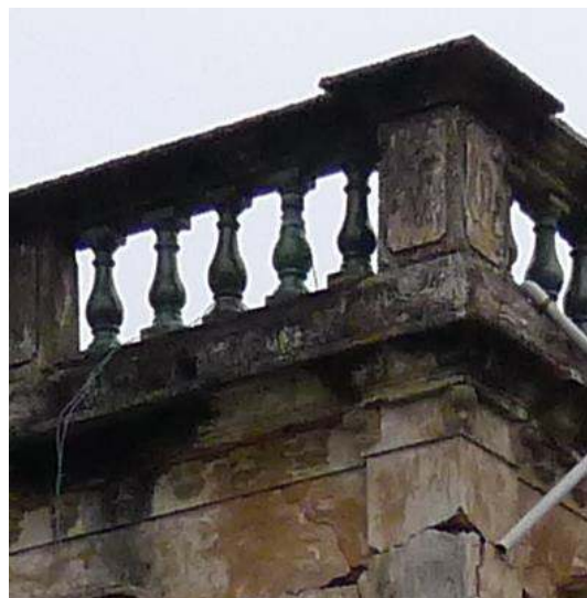
照片 2-3-10：許家洋樓背面屋頂近貌
