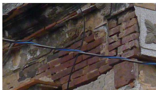
照片 2-5-2：磚牆本體(右側接近牆頂)
