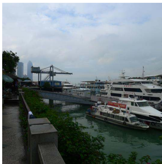
照片 2-3-2：舊水仙宮碼頭現貌
