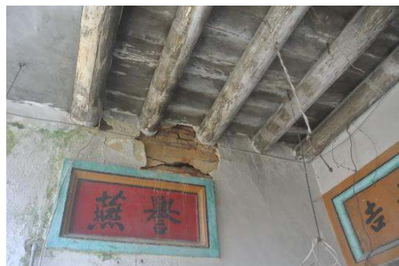
照片 3-3-7：一樓外廊上方桁木構件
