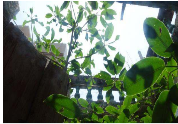
照片 3-3-32：左前房上方樓板塌落
